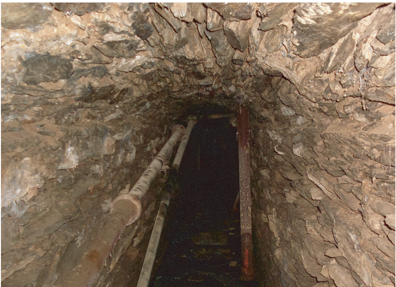
Abb. 11: Stollenmundloch des Herminenstollens (oben) und Blick in den Stollen (unten).
