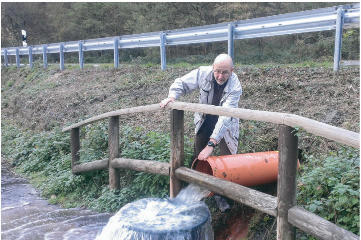
Abb. 12: Blick in den Lahnstollen (oben) und Schüttungsmessung am Auslauf des Lahnstollens (unten).
