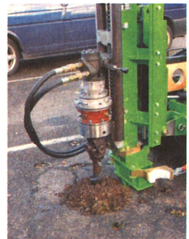
Schnecken-Drehbohren bis 700 Nm
