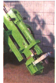
Rammkernbohren mit Hydraulikhammer
