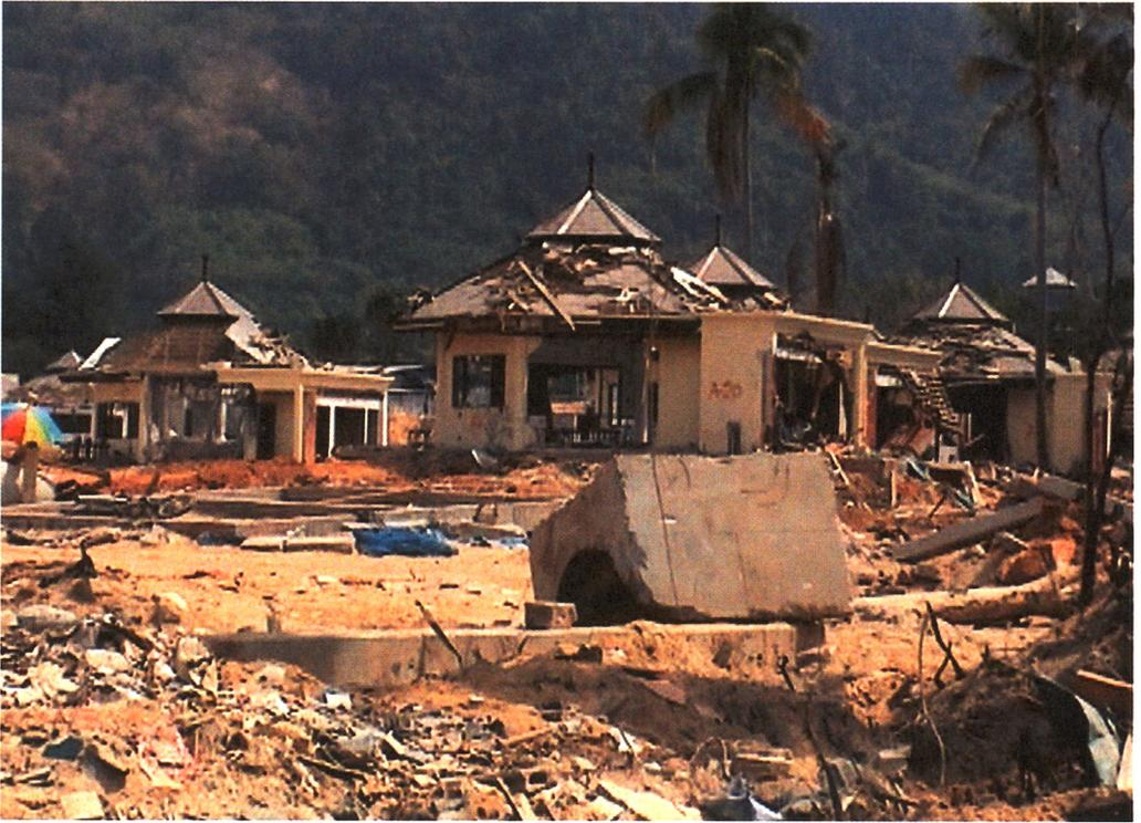
**Abb. 2: Zerstörungen an Häusern und vor allem Dächern ermöglichen die Messung der Wellenhöhe, hier bei Khao Lak mit ca. +12 m über Hochwasserniveau.**
