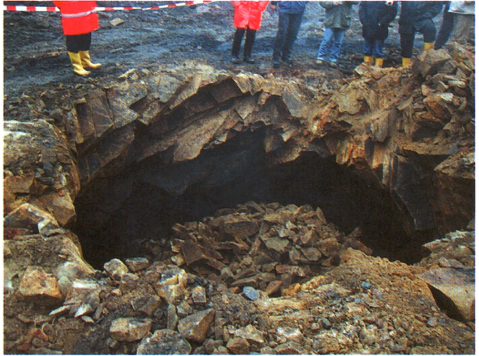
Abb. 5: Tagesbruch in einer Baustelle über einem kleinen Schacht nahe einem abbauwürdigen Flöz in steiler Lagerung (Foto J. Becker, Straßenbetrieb NRW)
