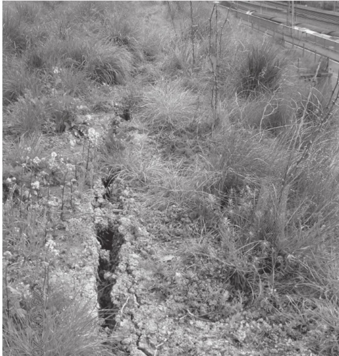
Abb. 12: Schadensbild der Querterrassierung in Linz am Rhein. Das Foto zeigt eine höhenlinienparallele Spalte mit einer Öffnungsweite sowie einem vertikalen Versatz von jeweils etwa 10 cm (Foto: U. SCHROEDER 2008).
