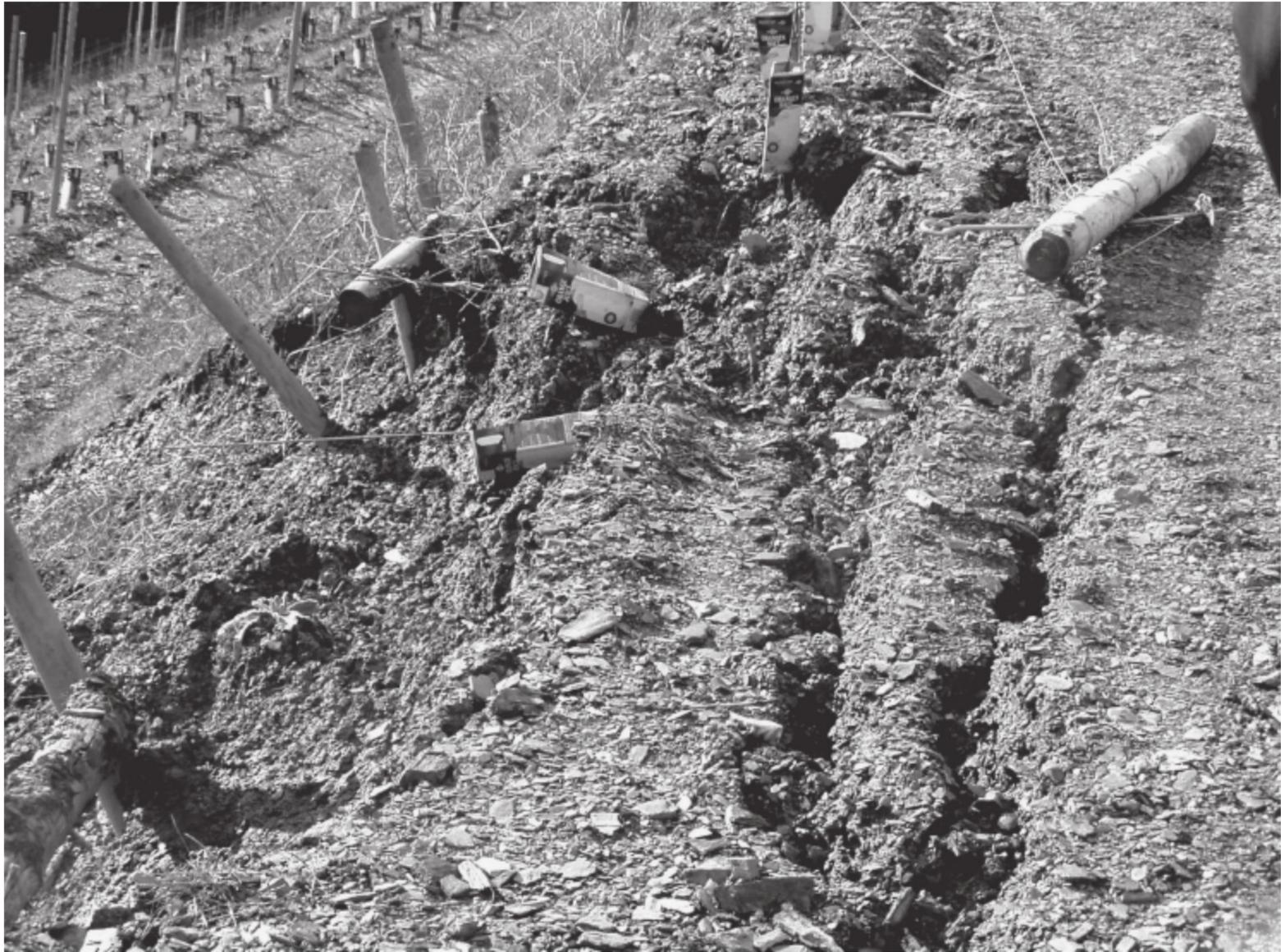
Abb. 10: Schadensbild in Serrig. Bei der Querterrassierung in Serrig traten staffelförmig angeordnete, höhenlinienparallele Abrisse auf. Provisorisch eingerammte Holzpflocke haben die Schadensentwicklung nicht aufgehalten (Foto: DLR Mosel, Dienstsitz Trier, 2008).
