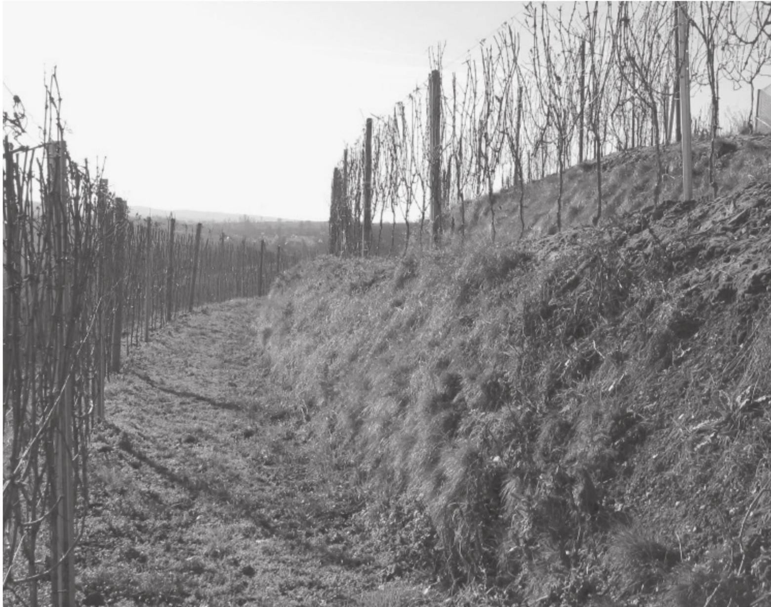
Abb. 7: Beispiel für eine neu angelegte Querterrasse bei Koblenz-Güls. Die Einzelterrassen sind befahrbar. Die Einzelböschungen weisen Neigungen  $> 45^\circ$  auf. Die Böschung im Vordergrund zeigt am Fuß eine Ausbauchung, was auf eine trotz Begrünung zu steile Böschungsneigung hinweist (Foto: A. WEHINGER 2008).
