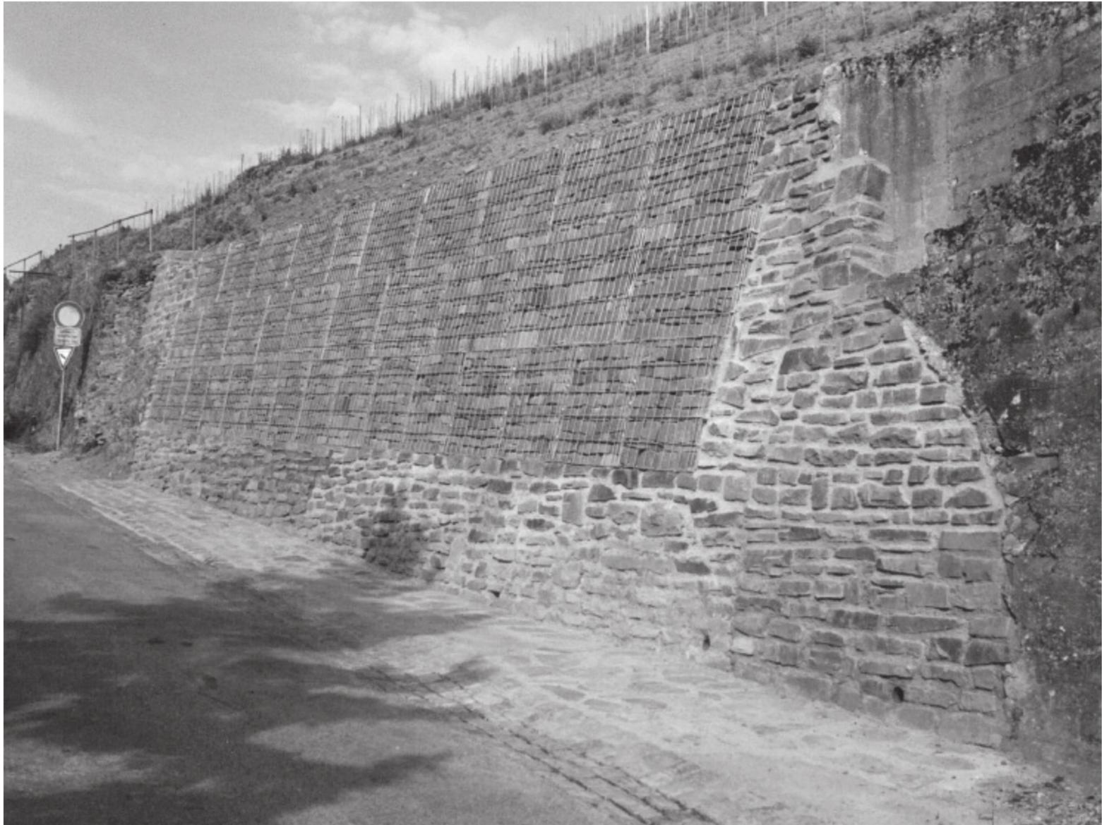
Abb. 9: Situation in Koblenz-Güls nach Sanierung des Schadensbereichs. Anstelle der alten Stützmauer wurden mit Natursteinen befüllte Gabionen angeordnet. Die Gabionen sitzen einer Schwergewichtsmauer aus Naturstein auf. An der Basis der Schwergewichtsmauer wurde ein Gründungsbalken aus Beton hergestellt. Das Foto entstand nur zwei Monate nach Eintritt des Schadens (Foto: U. SCHROEDER 2005).
