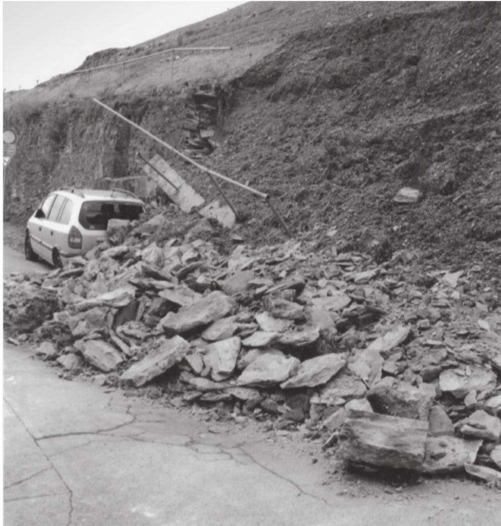
Abb. 8: Eingestürzte Mauer am Fuß des Weinbergs Bienengarten in Koblenz-Güls (Foto: U. SCHROEDER 2005).
