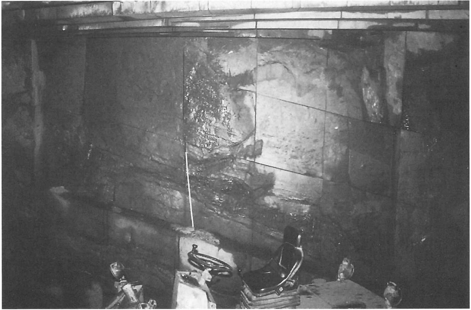
Abb. 8: Ausschnitt der Ortsbrust. Die Sägeschnitte wurden versuchsweise schiefwinklig angelegt (Abstand der Vertikalschnitte 0,90 m, Bildhöhe ca. 3,5 m).
