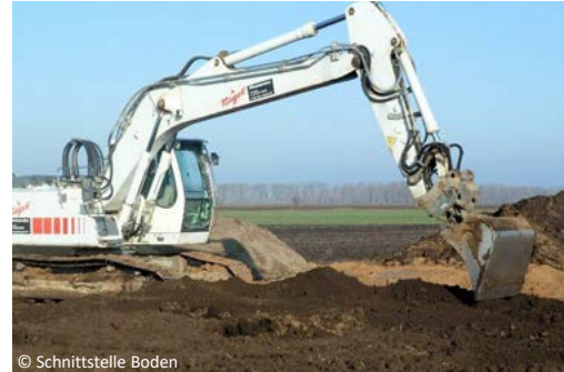
Herstellung einer durchwurzelbaren Bodenschicht
