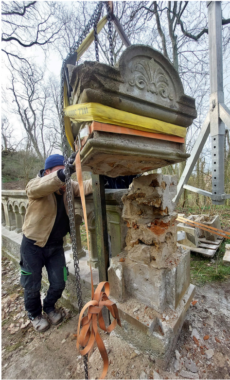
Demontage zerfallener Pfeiler (Foto: T. Gdanitz)
