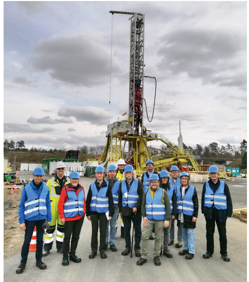
Abb. 2: Die Journalistengruppe vor der Bohranlage der Deutschen Erdwärme GmbH in Graben-Neudorf (Foto: L. Lich-Knight)
