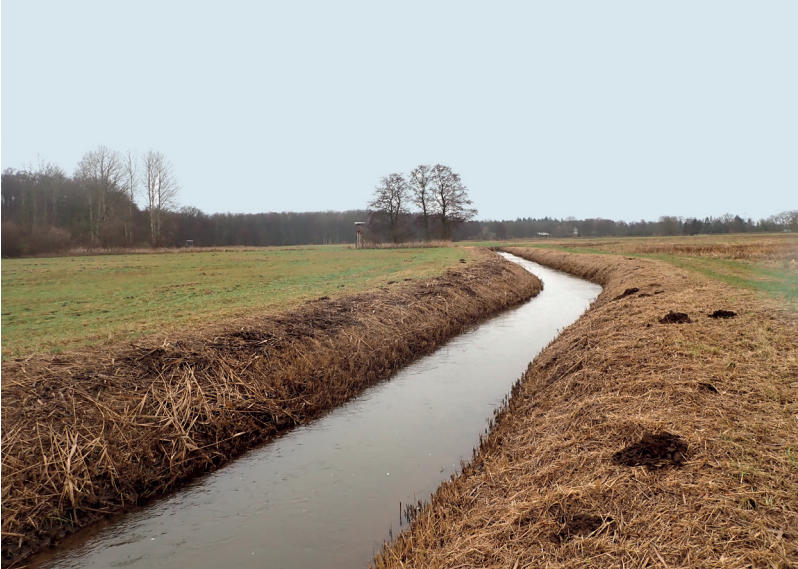
Abb. 3: Tief ausgebauter und begradigter Stöbber (Foto vom 04.01.22). Deeply expanded and rectified Stöbber (Photo 2022/01/04).
