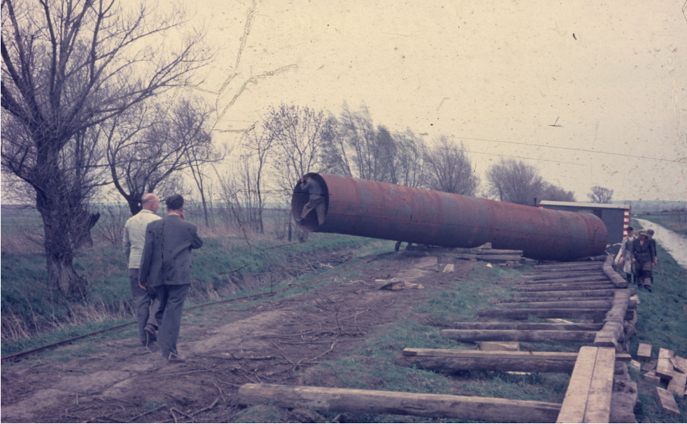
Abb. 2: Einbau von Entwässerungstechnik im Großen Bruch 1957. Installation of drainage technology in the Großes Bruch 1957.
