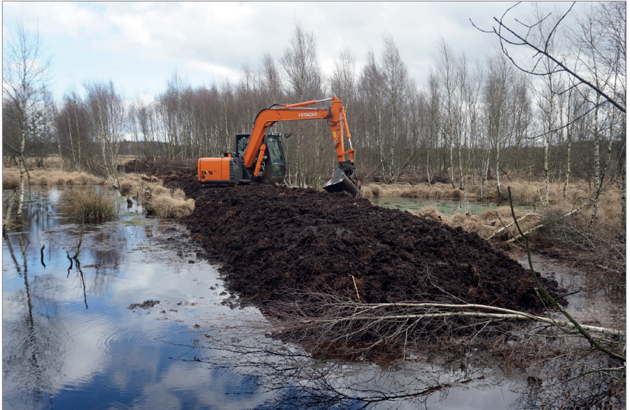
Abb. 5: Neubau eines Dammes (Foto: Christian Starkloff, 03/2022). New embankment (Photo: Christian Starkloff, 03/2022).
