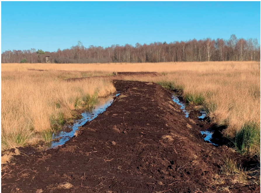
Abb. 2: Dammsanierung im Kernbereich der Bockholter Dose (Foto: Niels Gepp, 02/2023). Embankment rehabilitation in central area of Bockholter Dose (Photo: Niels Gepp, 02/2023).
