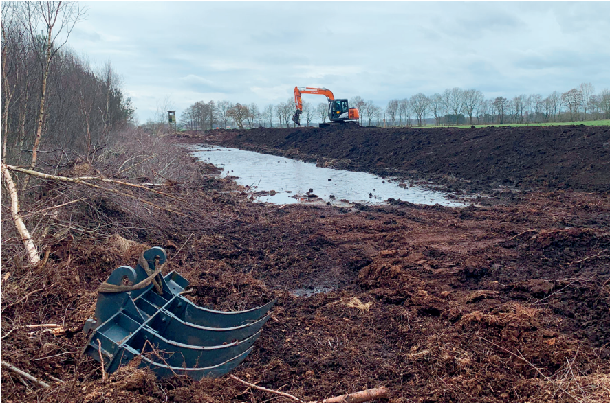
Abb. 3: Verwallungsarbeiten im Naturschutzgebiet (Foto: Niels Gepp, 01/2023). Embankment work in nature reserve (Photo: Niels Gepp, 01/2023).
