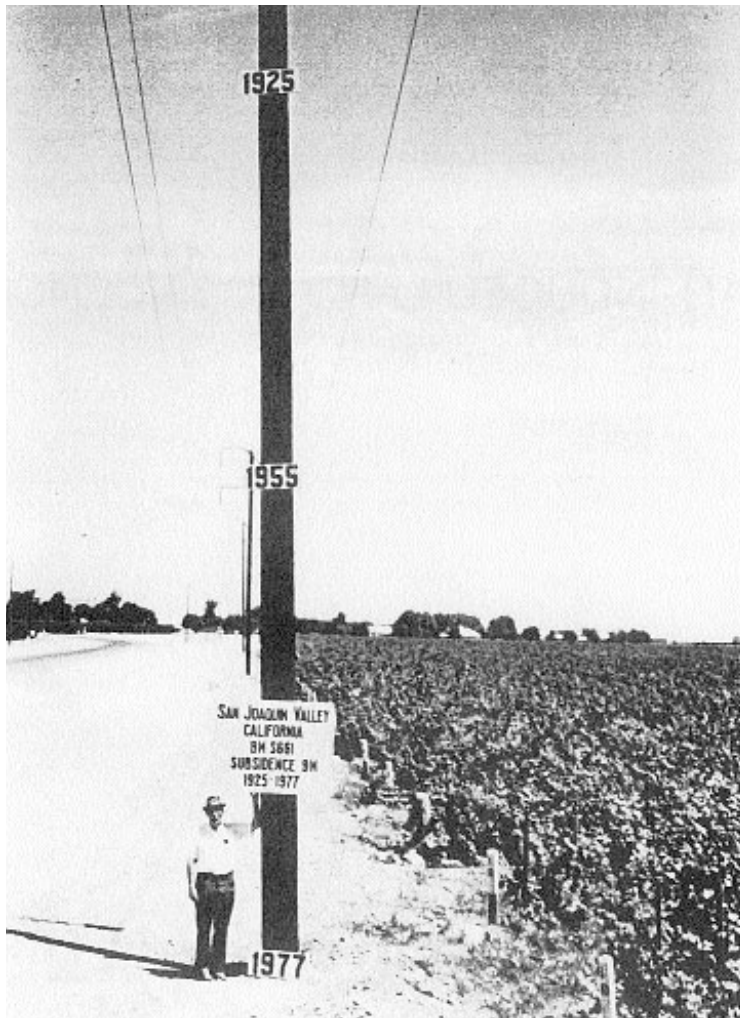
Abb. 2: Tiefste Landstelle auf intensiv genutztem Niedermoor im San Joaquin Valley in Kalifornien/USA, entstanden nach 9 m Höhenverlust (1927 - 1977) infolge Entwässerung und biochemischer Oxidation der organischen Substanz. (Aus: STEPHENS et. al. 1984).
