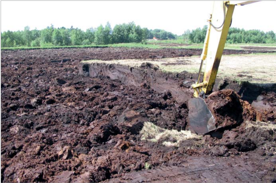
Abb. 2: Entnahme von Schwarztorf, Zurücksetzen der Krumentorfe und Abdecken mit Weißtorf Removal of highly decomposed raised bog peat, relocation of the top peat layer and cover with slightly decomposed raised bog peat
