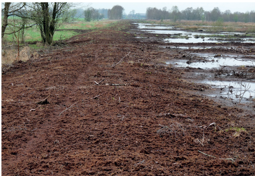
Abb. 7: Wiedervernässungsprojekt Hartshoper Moor: links die Geländehöhe außerhalb des eingestauten Bereiches, rechts der aufgequollene Moorboden nach der Wiedervernässung. Rewetting-project Hartshoper Moor: on the left ground level outside the dammed area, on the right swollen peatland surface after rewetting.
