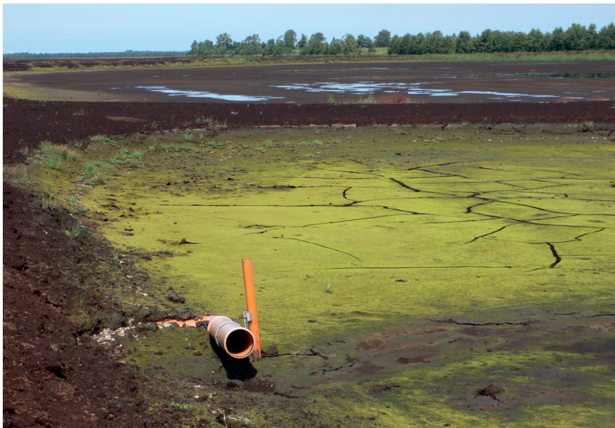
Abb. 10: Am Beginn der Wiedervernässung. Junge Polder mit Dämmen und Überläufen zur Rückhaltung von Niederschlagswasser im Westlichen Vehnemoor. At the beginning of the rewetting measures. Fresh polders with dams and overflows to retain rainwater in the western Vehnemoor.
