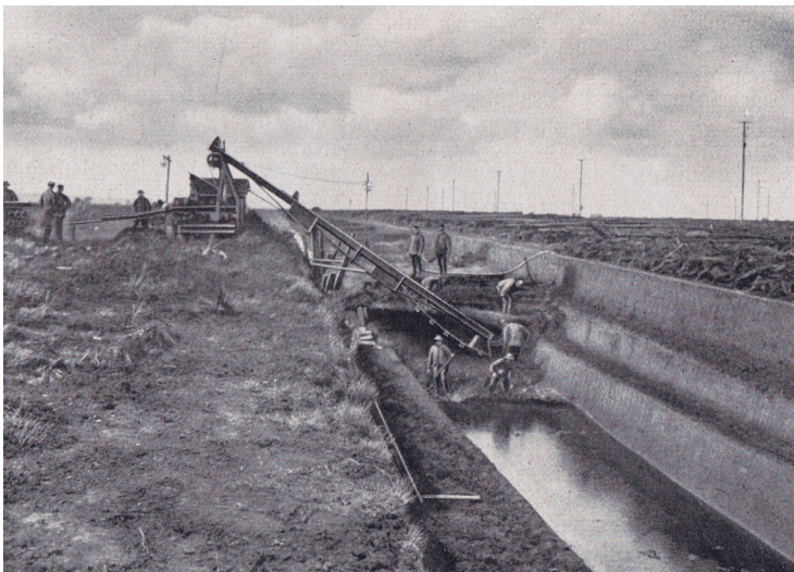
Abb. 5: Elektrisch betriebener Schwarztorfbagger in Wiesmoor. Brenntorfabbau für das Kraftwerk zur Verstromung. (Foto aus TACKE & LEHMANN, 1926).
