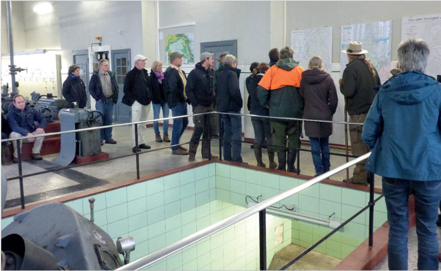
Abb. 4: Exkursionsgruppe im Pumpenhaus Steinschleuse (14.10.2017, Foto: Rowinsky)
