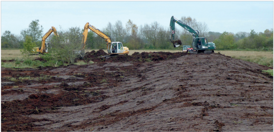
Abb. 3: Bagger bei der Erstellung eines Torfwalles im Dellstedter Birkwildmoor (13.10.2017, Foto: Rowinsky)
