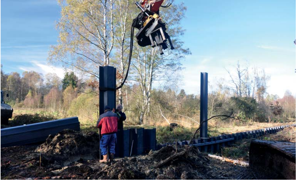
Abb. 6: Einbau von Spundwandbohlen aus Recycling-Kunststoff (Hartvinyl) Installing the sheet piles made of recycling plastic (hard vinyl)
