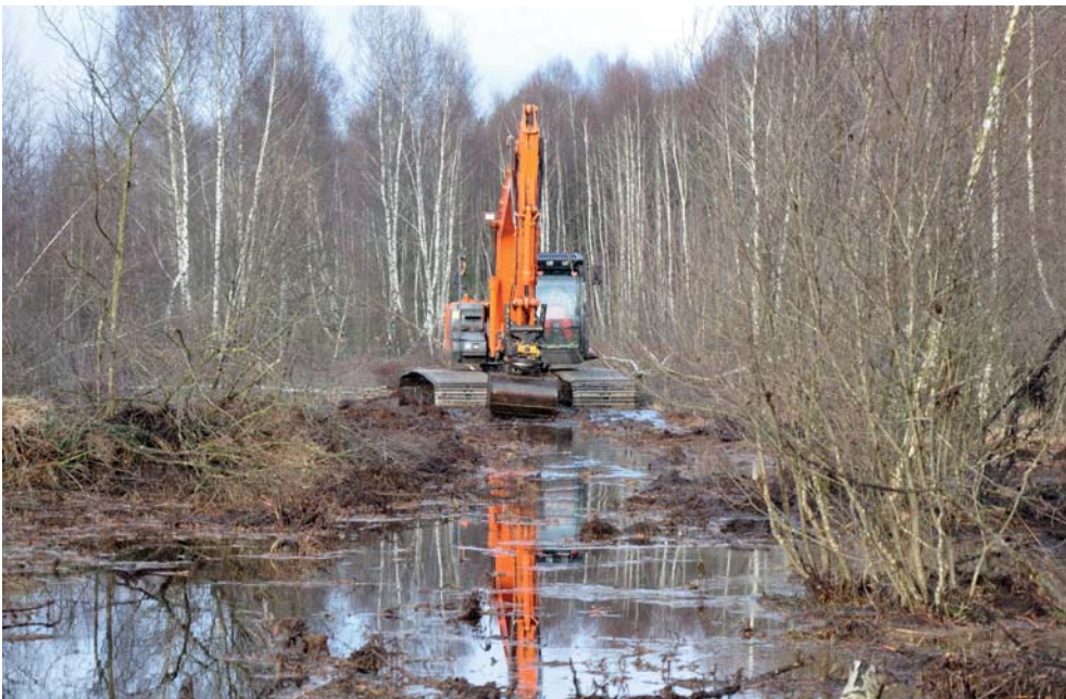
Abb. 4: Moorbagger mit extra breitem Kettenfahrwerk bei der Anlage einer Rieselmulde bei Hochwasser Shovel excavator with extra-wide caterpillar tracks constructing percolation depressions for flooding
