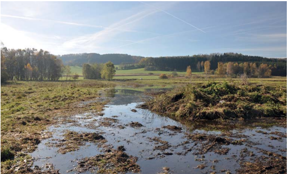
Abb. 7: Fertig gestelltes Dammbauwerk mit angestauter Sackungsmulde Finished dam with dammed-up water level in the slump hollows
