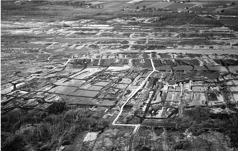
Abb. 4: Bau von Dämmen und Stauanlagen. Das Foto (unten) vom April 2005 zeigt die Wiedervernäsung. Das Wasser wird in den Poldern gehalten.
