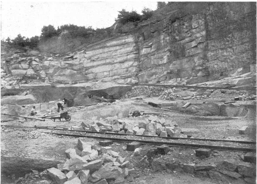
Granitbruch am Kretschamberg bei Qualkau. Bankung des Granits und Klüfte
