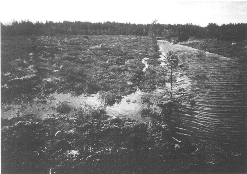
Abb. 3 Überfluteter Bereich der ehemaligen Dammschulter direkt vor dem Stauwehr Flooded part of the former shoulder of the ditch directly before the dam
