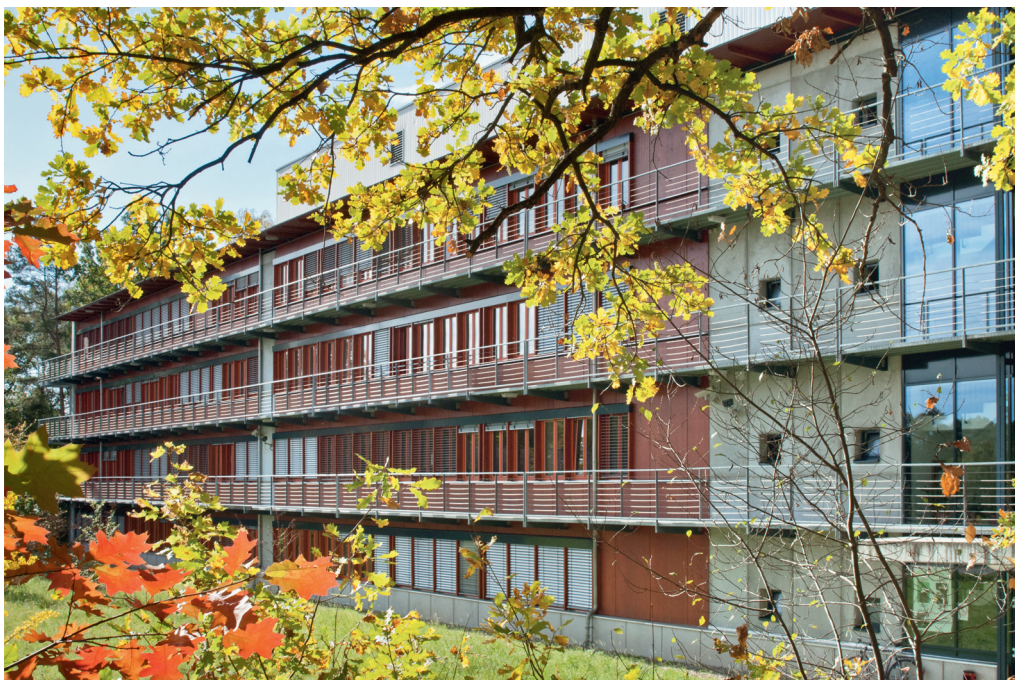
Abb. 10: A.-B.-Meyer-Bau. Arbeits- und Depotgebäude der Senckenberg Naturhistorischen Sammlungen Dresden, errichtet 1997 bis 1999. Foto: Barbara Bastian, SNSD
