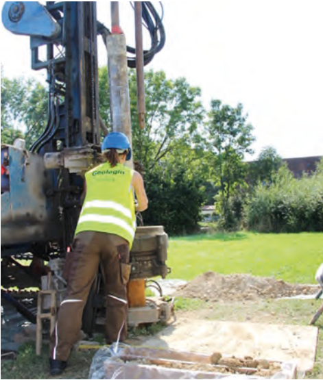
Ungewohnte Arbeit am Bohrgerät
