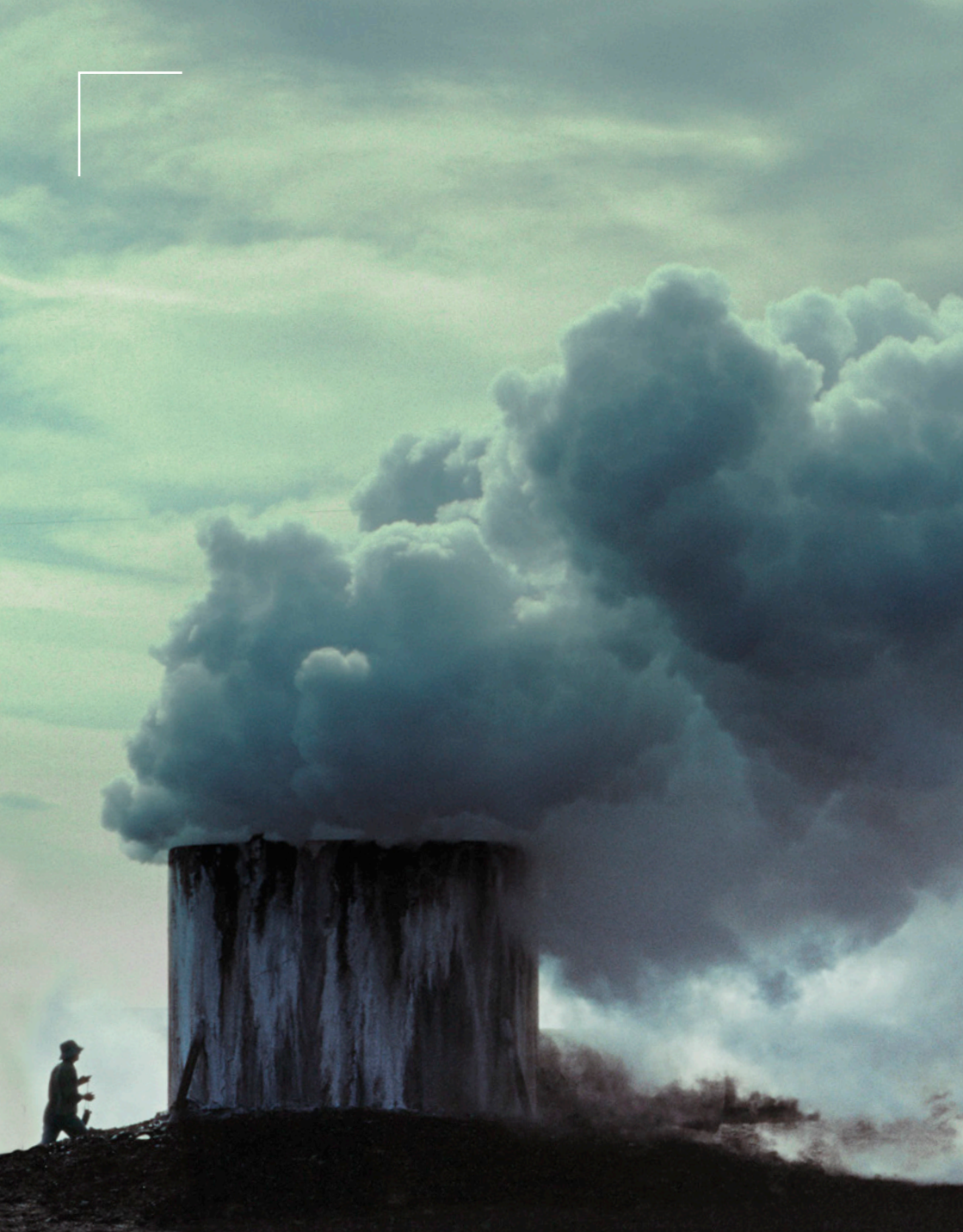
Wasserdampf steigt aus dem Entlastungstrichter einer nicht genutzten Geothermiebohrung im Theistareykir Fumarolenfeld (Island). Der abgelassene Dampf mit einer Leistung von einigen Megawatt wurde 2004 benutzt, um ein nahegelegenes Kartoffelfeld zu bewässern (Foto: H. Kudrass).
