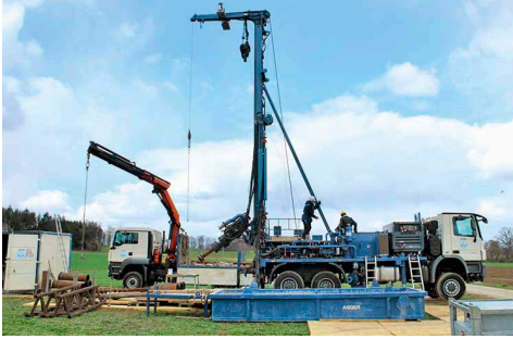
Bohranlage bei Winterstettenstadt (Foto: LIAG)
