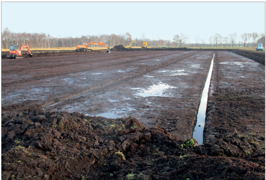
Abb. 3: Bodenabtrag zur Einrichtung des Anzuchtpolders auf ehemaligem Hochmoorgrünland. Removal of top soil to set up the culture polder on former bog grassland.
