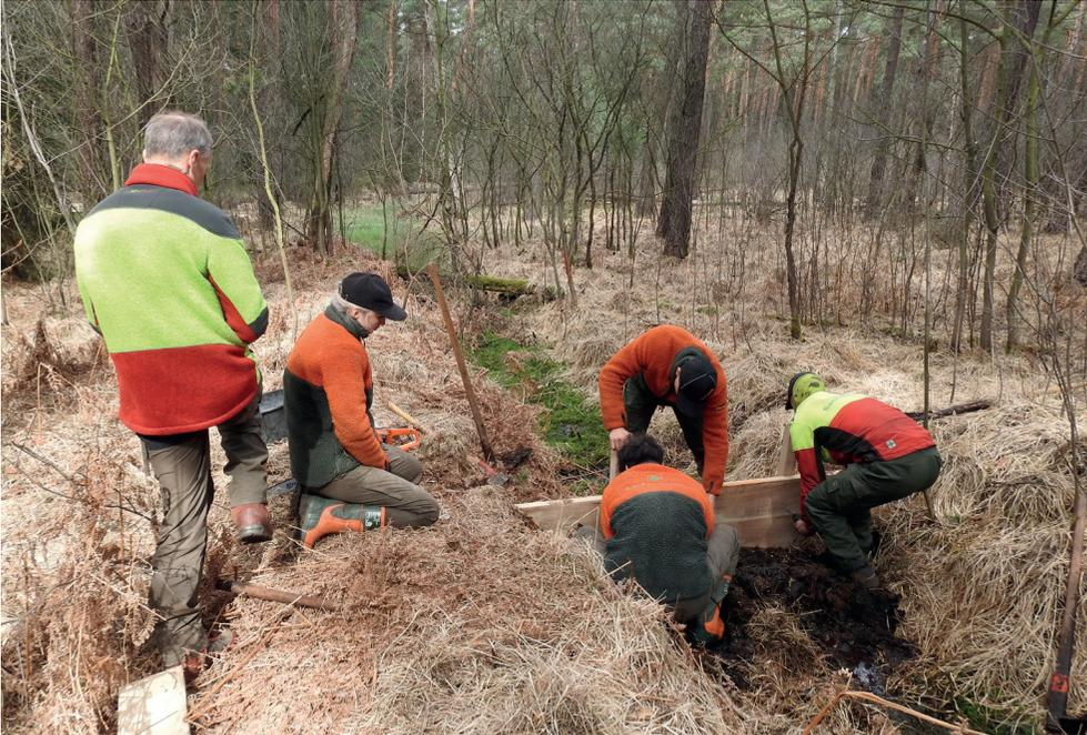
Abb. 2: Die Auszubildenden verschließen mit unbehandelten Eichenbohlen die flachen und schwach fließenden Entwässerungsgräben der alten Teichanlage (Aufn.: M. Schrack, 22.04.2021).
