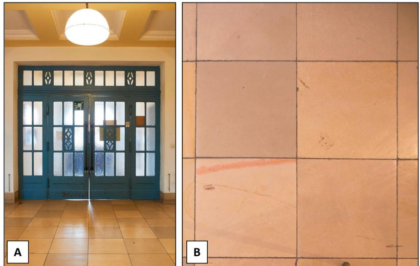
**Abb. 26:** Der Innenbereich hinter der Eingangstür aus transparentem Antikglas mit Ornamentik weist einen Boden aus Solnhofener Plattenkalk auf (A). B – Leicht unterschiedliche bräunliche und beige Typen des Solnhofener Kalksteins sowie eine Platte mit charakteristischem roten Farbstreifen.
