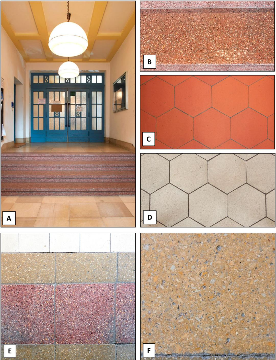
**Abb. 25:** Bereich des Haupteingangs mit Bodenplatten aus Solnhofener Kalkstein und Treppen aus rötlichem, grobkörnigem Kunststein (B). Achteckige Kacheln aus rotem (C) und weißem (D) Kunststein, sowie weiße (E) und braune, pigmentierte (F) Kunststeine.
