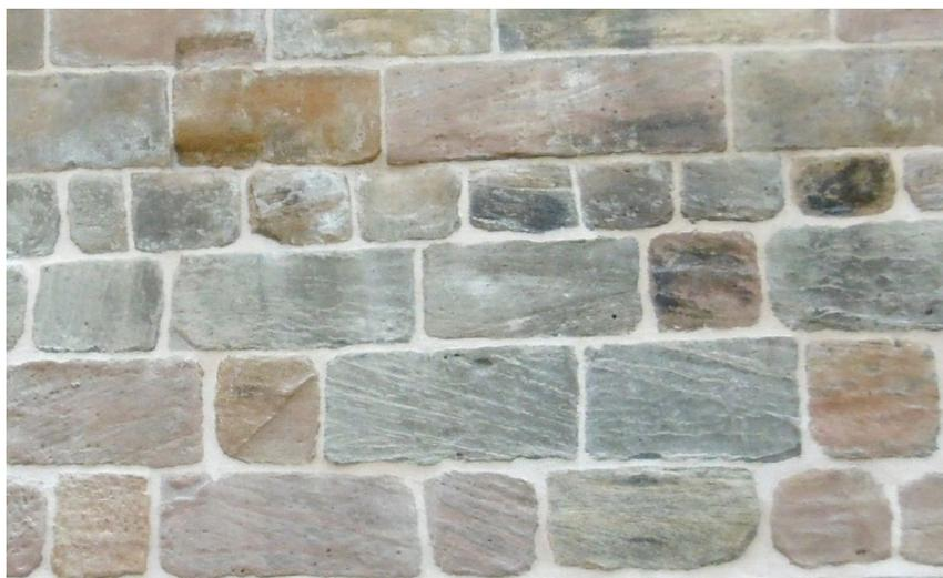
**Abb. 2:** Ausschnitt aus der 2020 restaurierten Nördlichen Stadtmauer in Erlangen mit Sandsteinquadern, die häufig Schrägschichtung zeigen. Die Sandsteine wurde vorwiegend in verschiedenen Steinbrüchen am Burgberg gebrochen. Die Maße der Quader betragen mit leichten Abweichungen 40 x 40 x 40 cm und 40 x 40 x 80 cm; dabei ist die Lage von Quer-Riegeln zu berücksichtigen.
