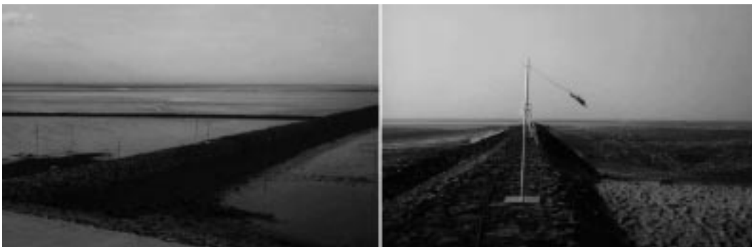
Abbildung 3.10: Ansicht der Buhnen, an denen Strömungsmessungen vorgenommen wurden. Die Buhnenhöhen betragen 1.6 m (links) und 2.6 m (rechts).
