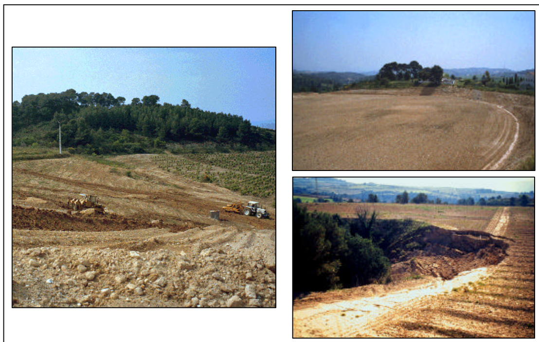
Figura 1.5. Diseño de parcelas para nuevas plantaciones de viña. Izquierda: movimientos de tierra. Derecha superior: parcela tras los movimientos de tierra y nivelación. Derecha inferior: colapso de la zona de barranco rellenada en una nueva plantación de viña tras las primeras lluvias (foto: A. Meyer).
