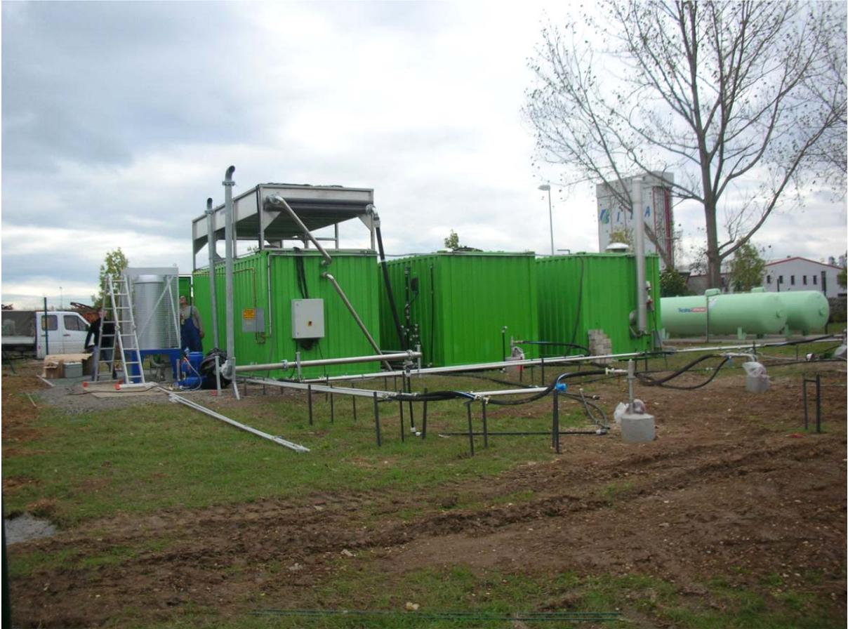
**Abbildung 22: Mobile thermische *in situ*-Sanierungsanlage in modularer Bauweise (MOSAM)**
