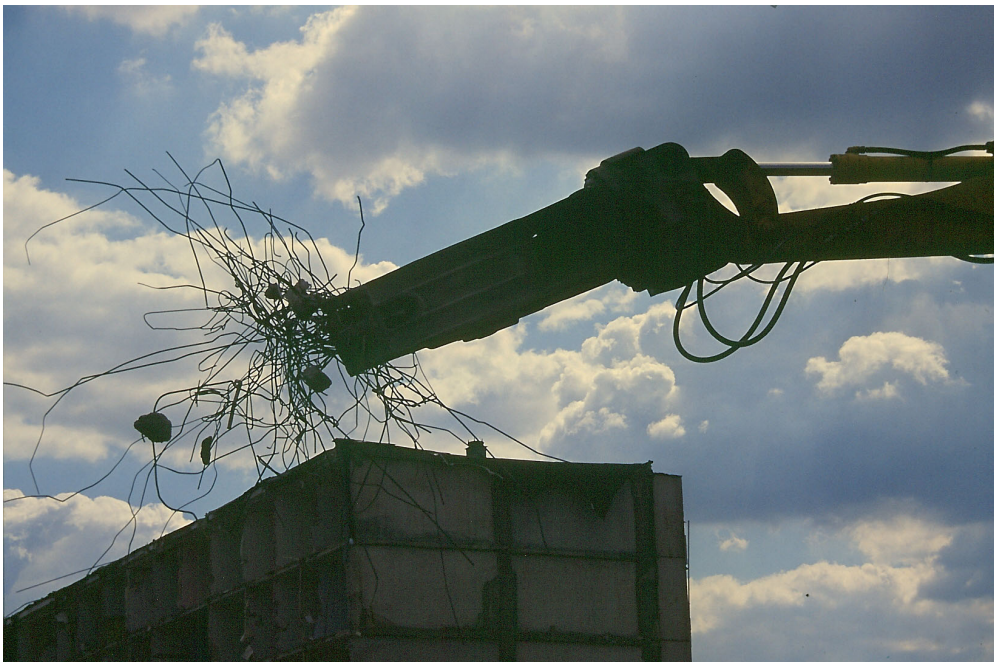
Foto 9: Entfernung des Metalls aus den Betonplatten
