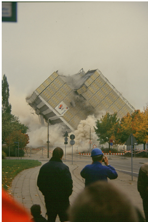
Foto 7: Sprengung „Mittelganghaus“ II (Quelle: eigenes Foto)
