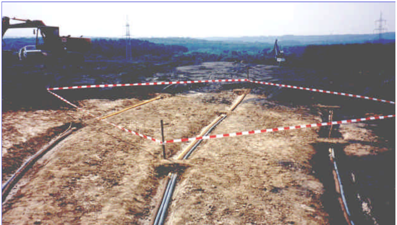
Bild A 5.6: Einbau der Flächendrainage auf Station 2a
