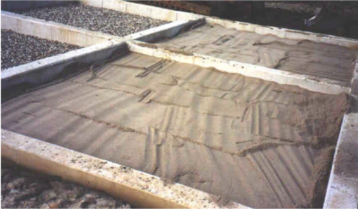
Bild A 5.5: Betonwanne mit Kies-Sandfüllung (Oktober 1998)
