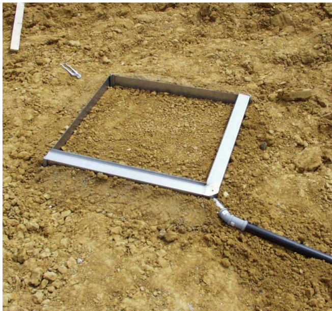
Abb. 4.11: Einbau Kastenrahmen zur Messung Oberflächenabfluß Versuchsfelder Lichtenberg.
