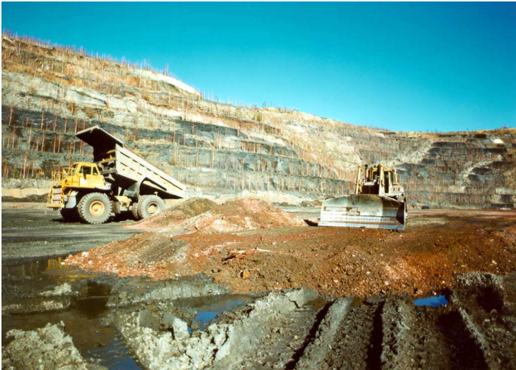
Abb. 3.7: Tagebaurestloch Lichtenberg: Rückverfüllung der Bergmassen, Einbau des Haldenmaterials in 1,2 m mächtigen Lagen und Verdichtung auf Werte der Trockenrohdichte von \geq 2,0 \text{ g cm}^{-3} durch Überfahrt.
