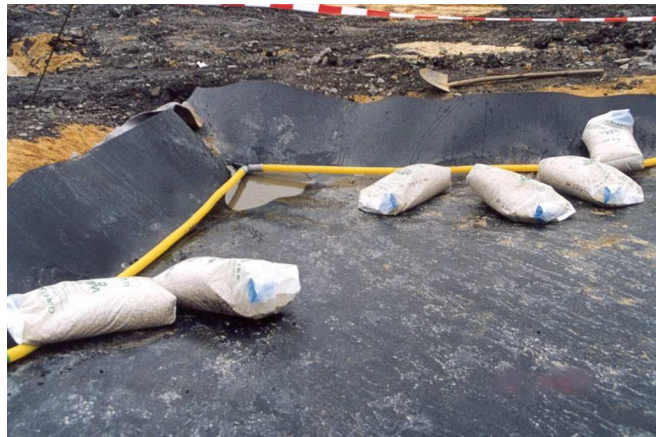
Abb. 4.7: Lysimeter Versuchsfelder Lichtenberg: Bau der Dränage in der Folienwanne.
