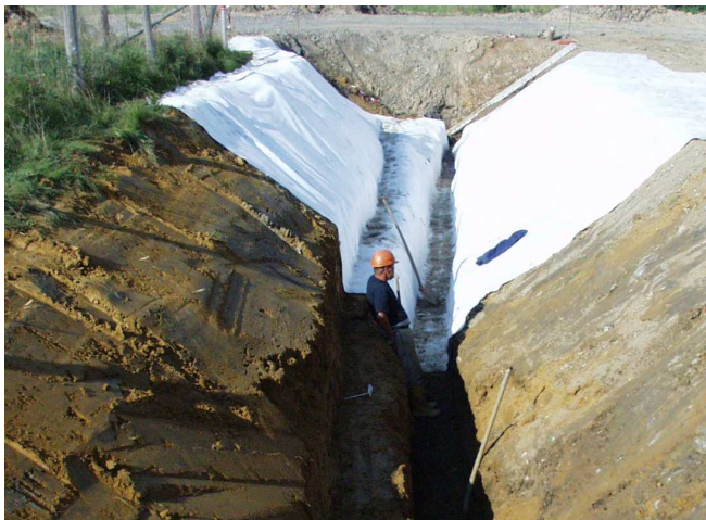
Abb. 4.10: Bau der Dränagen Versuchsfelder Lichtenberg (September 2002). VF 1, Graben zum Einbau der Folien und Dränrohre, mit aufgelegtem Geovlies.
