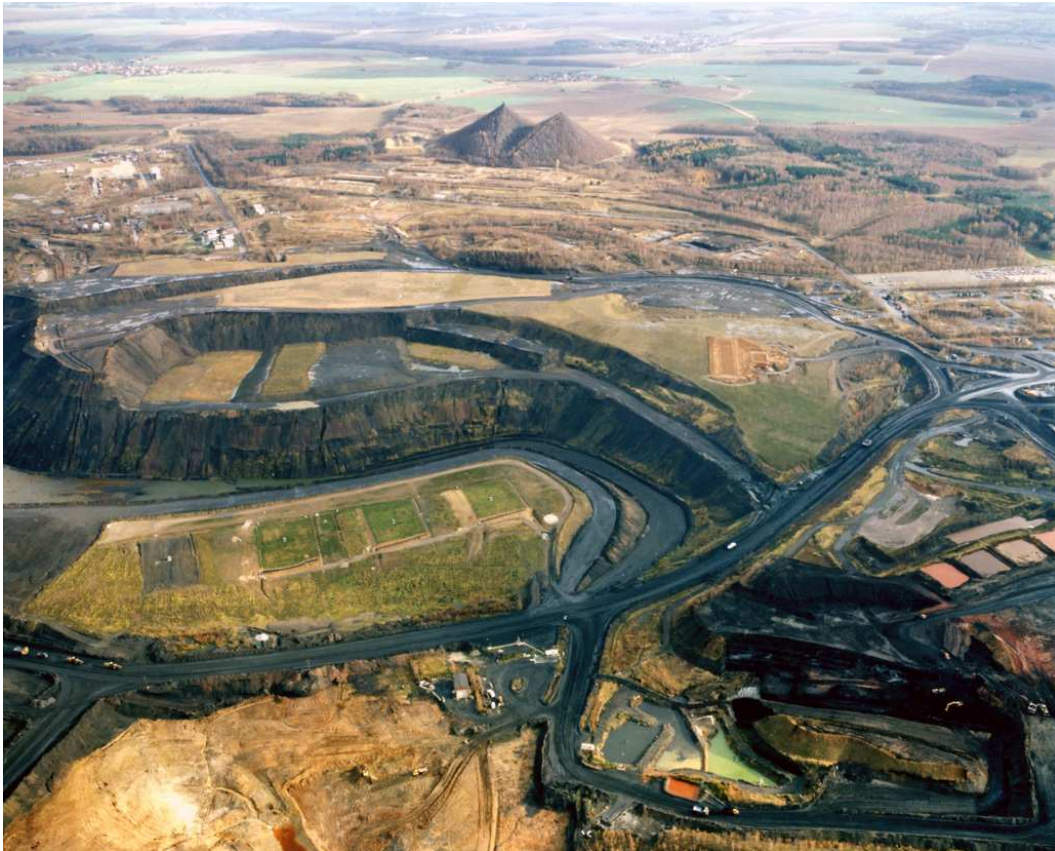
Abb. 4.3: Versuchsanlage Lichtenberg (Dezember 2002): Blick von Westen auf den verfüllten Westrand des ehemaligen Tagebaus Lichtenberg (sogenannter Kippbereich 3) mit den vier Versuchsfeldern VF 1 (rechts, S) bis VF 4 (links, N). Im Vordergrund und rechts sind Sickerwasserbecken und Verrieselungsflächen auf der Absetzerhalde zu erkennen; im Hintergrund das Tagebaurestloch Lichtenberg mit Innenkippenbereichen sowie die Spitzkegelhalden Reust (vgl. auch Abb. 3.2 und 4.4).
