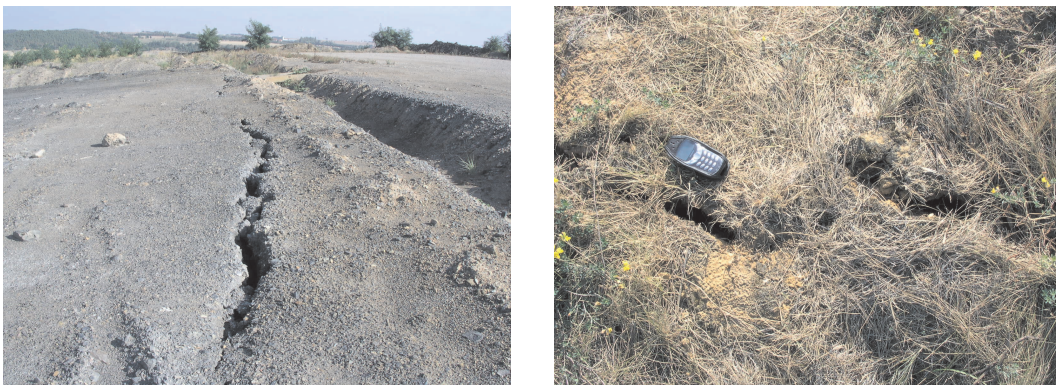
Abb. 5.23: Austrocknungsbedingte Ribildung im Rekultivierungsschichtsubstrat, Juni 2001: (links) VF 1 (rechts) VF 3.
