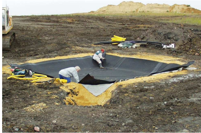
Abb. 4.6: Lysimeter Versuchsfelder Lichtenberg: Bau der Folienwanne.
