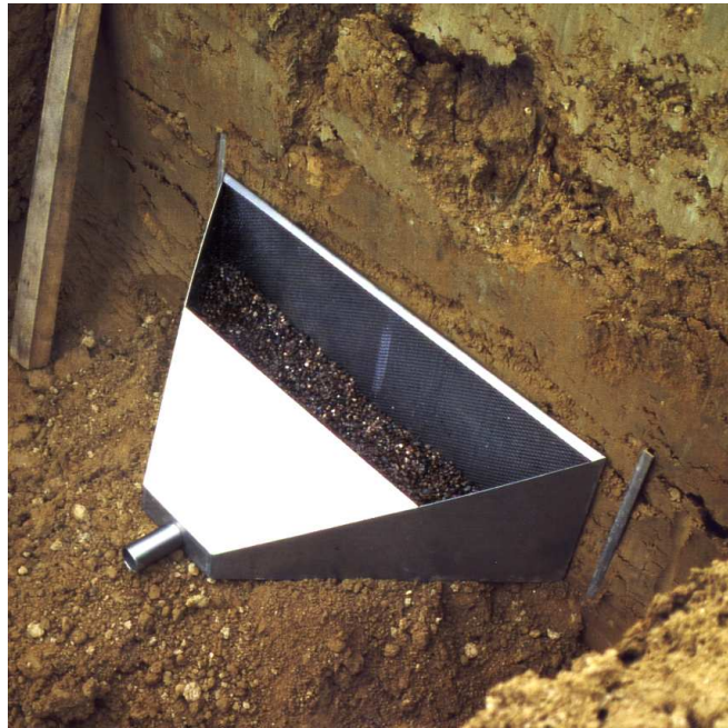
Abb. 4.8: Einbau des Auffangkastens zur Erfassung des hypodermischen Abflusses, VF 1.
