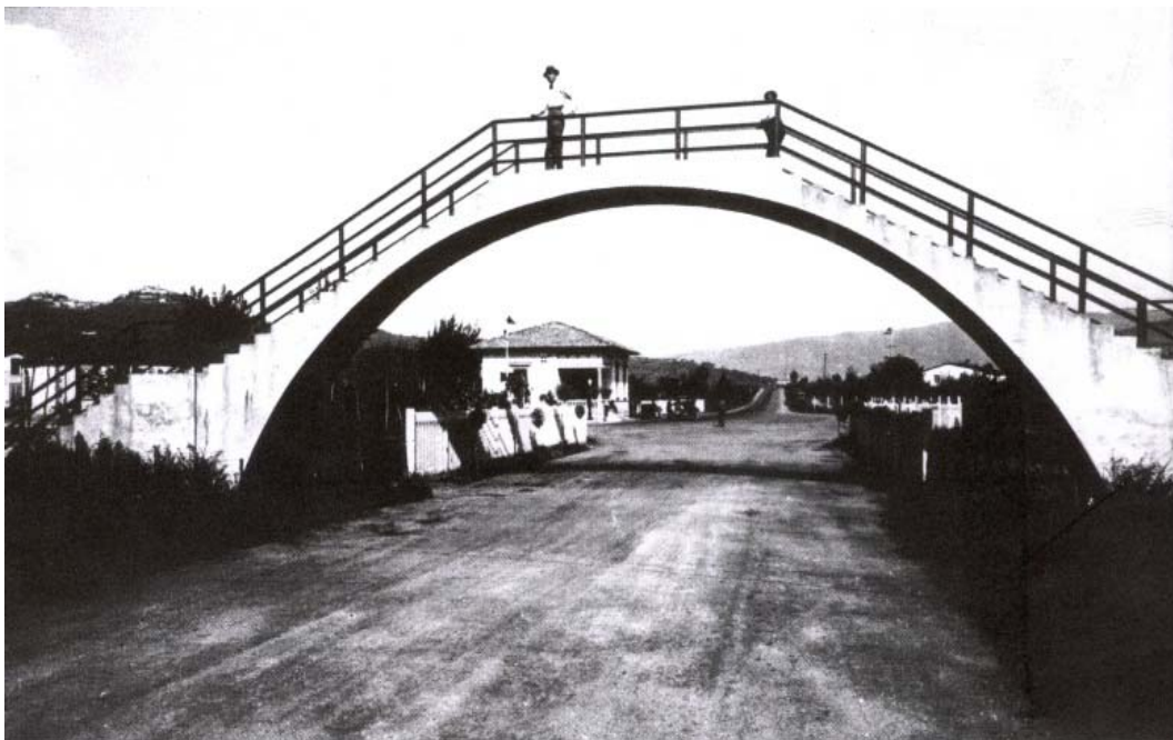
Abb. 42: Fußgängerüberführung über die Autobahn Firenze–Mare, ca. 1933 515
