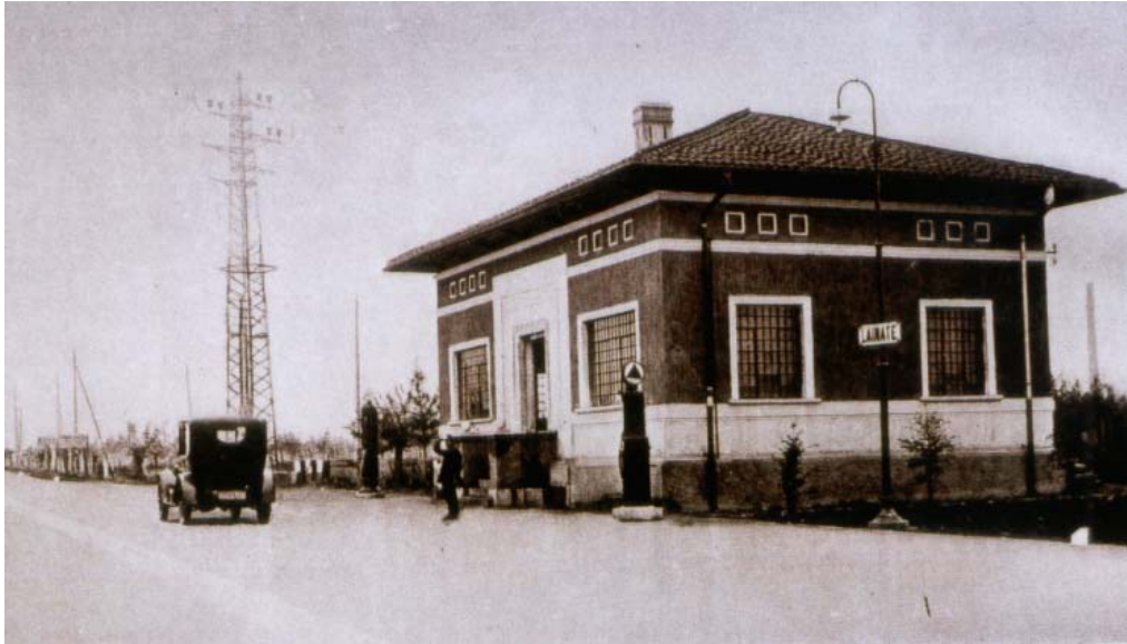
Abb. 48: Wärterhäuschen an der Autobahn Milano–Laghi, ca. 1925 545
