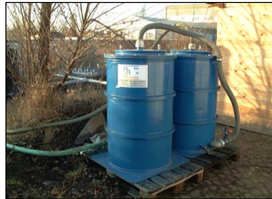
Abb. A13 Anschluss der Filterbrunnen an die Bodenluftabsaugung ( oben ), Wasserabscheider und Gebläse ( links ) und Aktivkohlefilter ( rechts ) als Bestandteile der konventionellen BLA
