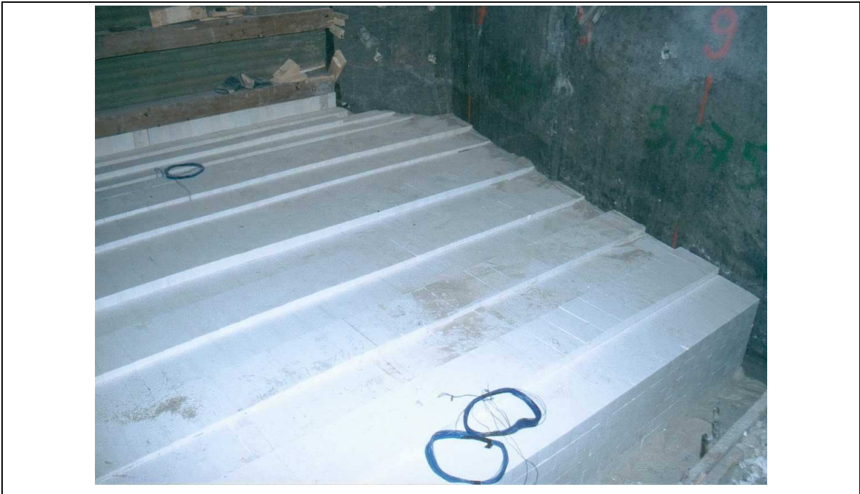
Abbildung B56: Einbau des statischen Widerlagers: unterer Bereich, Ansicht von der Luftseite
