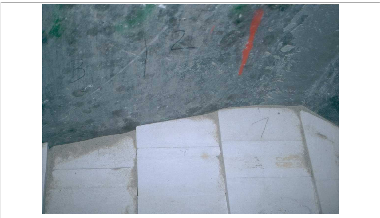
Abbildung B57: Einbau des statischen Widerlagers: Detail, Kontaktfuge zum Gebirge
