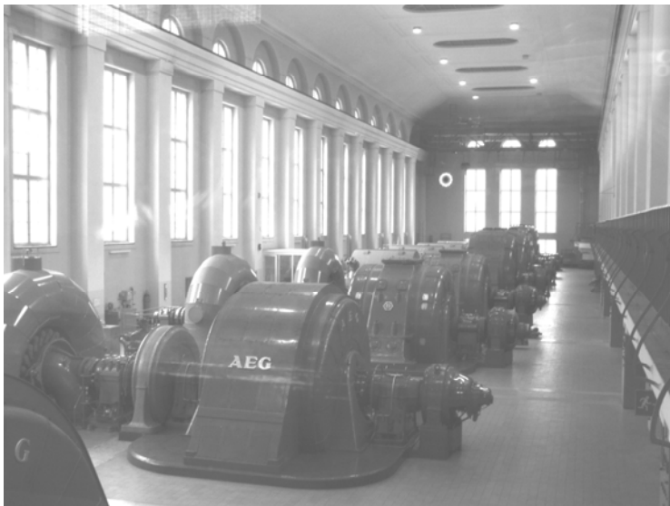
Abb. 2: Turbinenhaus. Foto: Witek
