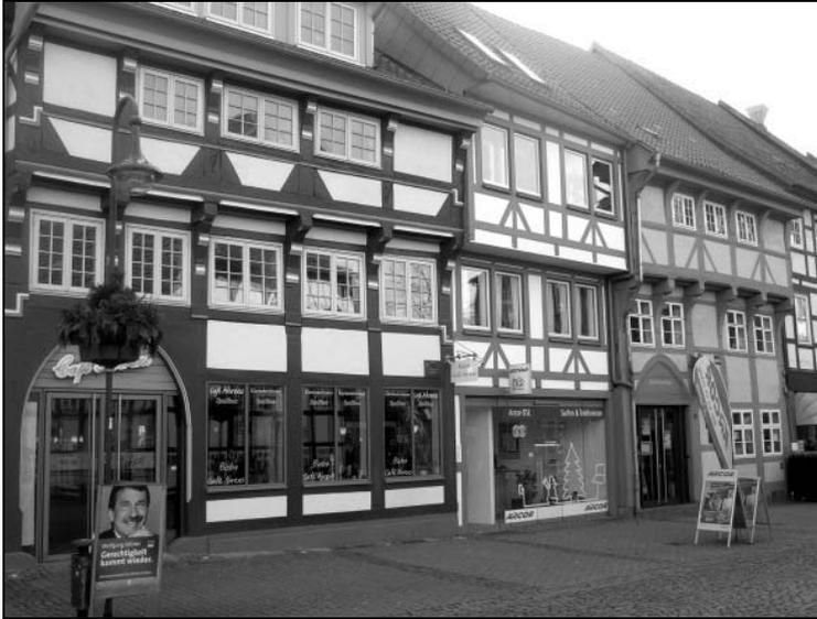
Abb. 8: Bürgerhäuser aus dem frühen 16. Jh. in Northeim. Die Fassaden der Häuser sind originalgetreu restauriert worden. Bei den anderen Gebäuden sind recht unterschiedliche Veränderungen der Erdgeschossfassade durch Schaufenster zu beobachten. Während die Außenwerbung dezent zurückhaltend ist, stören die auf dem Bürgersteig stehenden „Personenstopper“. (Foto: Busse)
