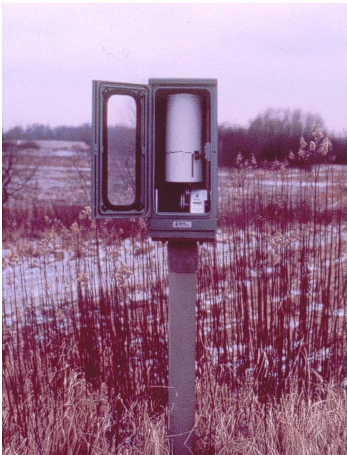
Abb. 4.3.3.2.3: Mechanischer Pegelschreiber zur Grundwasserstandsaufzeichnung
