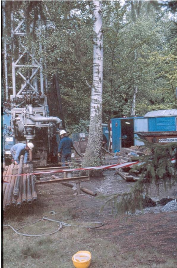
Abb. 3.2.1.16: Lufthebebohrung
