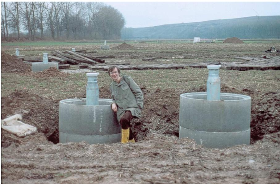
Abb. 3.2.3.2.7: Verstärkter Schutz von Grundwassermessstellen durch Schutzrohre aus verzinktem Stahl und Betonringe im Bereich landwirtschaftlich bewirtschafteter Flächen (Testfeld Horkheimer Insel) (Foto: Th. Ptak)
