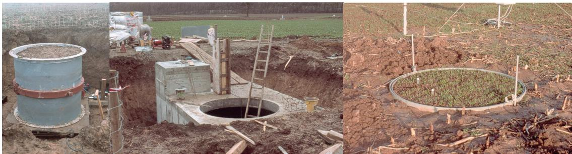
c) wägbares Monolith-Lysimeter der Universität Hohenheim (Testfeld Horkheimer Insel), von links nach rechts: Bodenmonolith von 2 m<sup>2</sup> Fläche und 2 m Höhe; Lysimeterkeller im Bau; in die Umgebung eingepasstes Lysimeter mit frischer Einsaat
