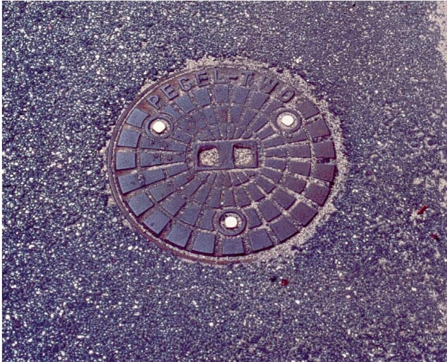
Abb. 3.2.3.2.5: Wasserdicht schließende Straßenkappe
