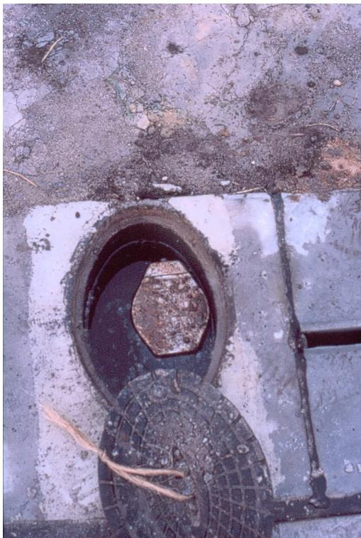
Abb. 3.2.3.2.4: Hydrantenkappe mit unzureichendem Arbeitsraum bei einer Grundwassermessstelle DN 100
