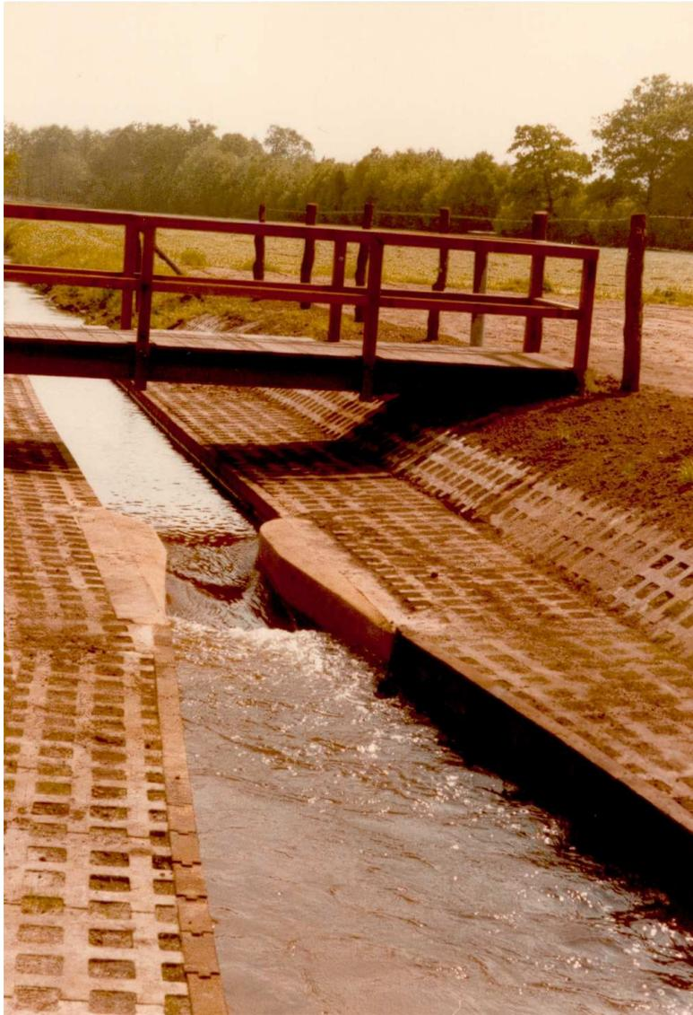
Abb. 2.2.2.4: Messstrecke mit Venturirinne zur Messung des Abflusses (Foto: Hamburger Wasserwerke GmbH)
