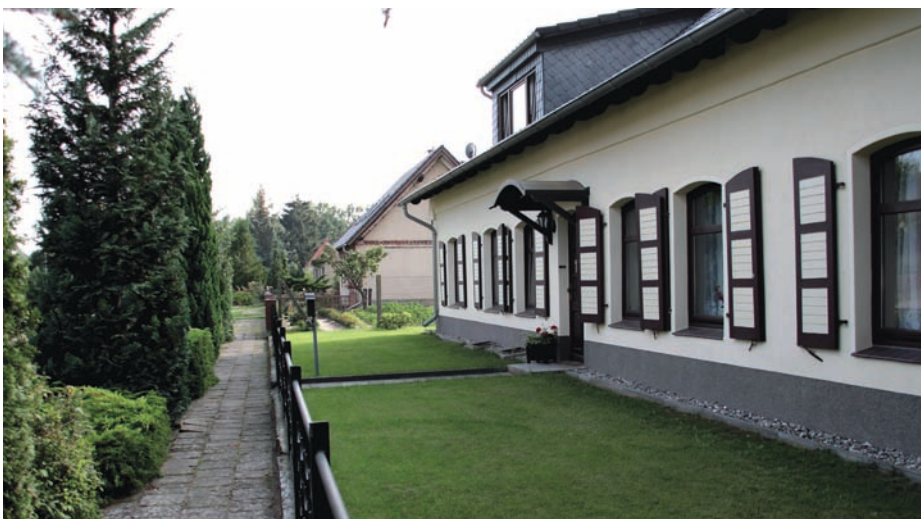
Ehemalige Häuslerei und Wohnhaus des Fischers The fisherman's former smallholding (Häuslerei) and living building
