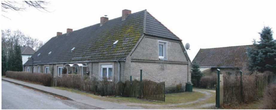
Ehemaliger vierhüsiger Forstarbeiterkaten Former forest worker cottage for four families
