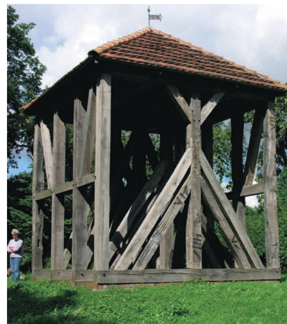
Der 2003 restaurierte hölzerne Glockenstuhl Wooden bell frame renovated in 2003
