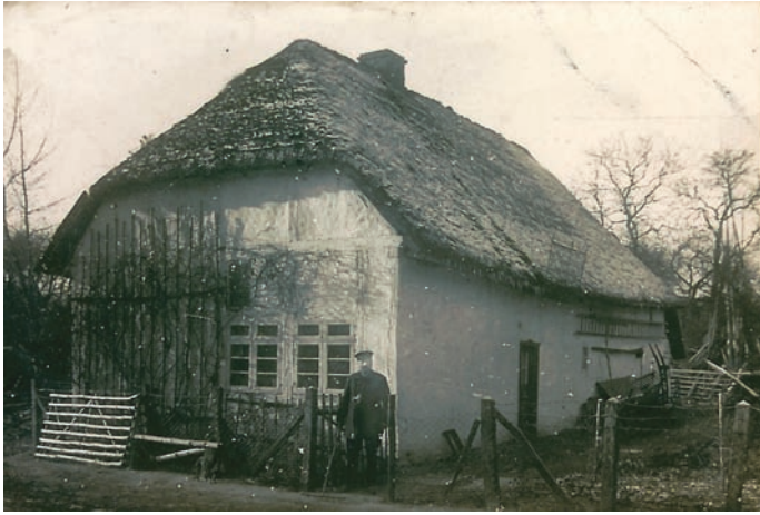
Ehemalige Büdnerlei 5, Bahnhofstr. 55 Former smallholding (Büdnerlei) 5, Station Street 55
