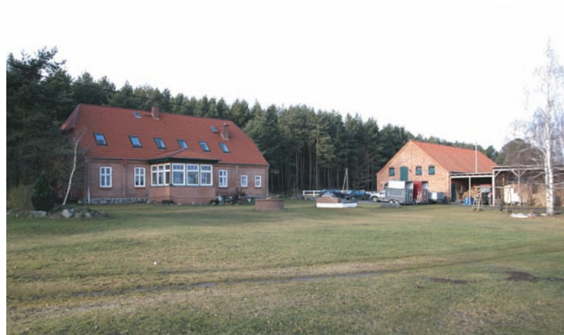
Dobbin Ausbau, Hofansicht mit denkmalgeschütztem Bauernhaus und Pferdestall Dobbin farmstead on long-lease land, view of farm courtyard with listed farm house and stable
