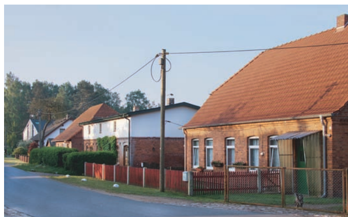
Ehemalige Häuslereien an der Straße nach Hinrichshof Former smallholdings (Häuslereien) along the road to Hinrichshof
