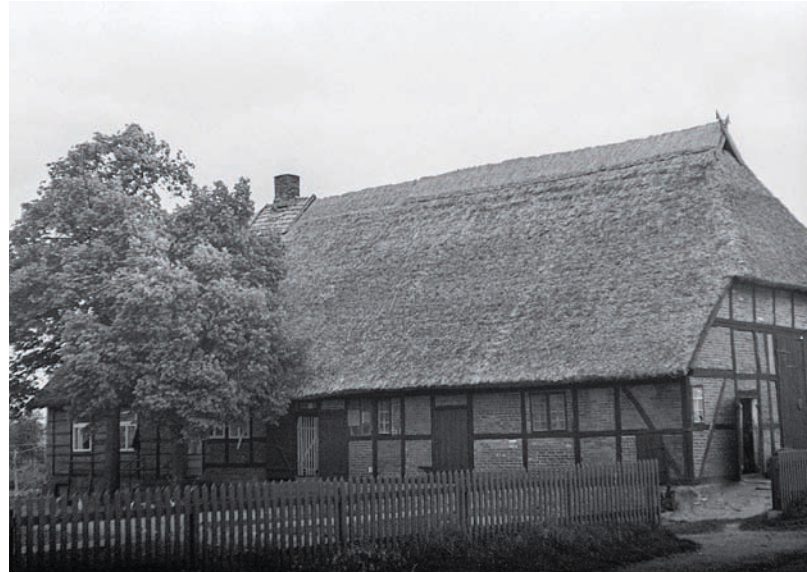
Hallenhaus in Dobbertin aus dem Jahr 1862 (Zustand 1968) Aisled house in Dobbertin from 1862 (condition 1968)
