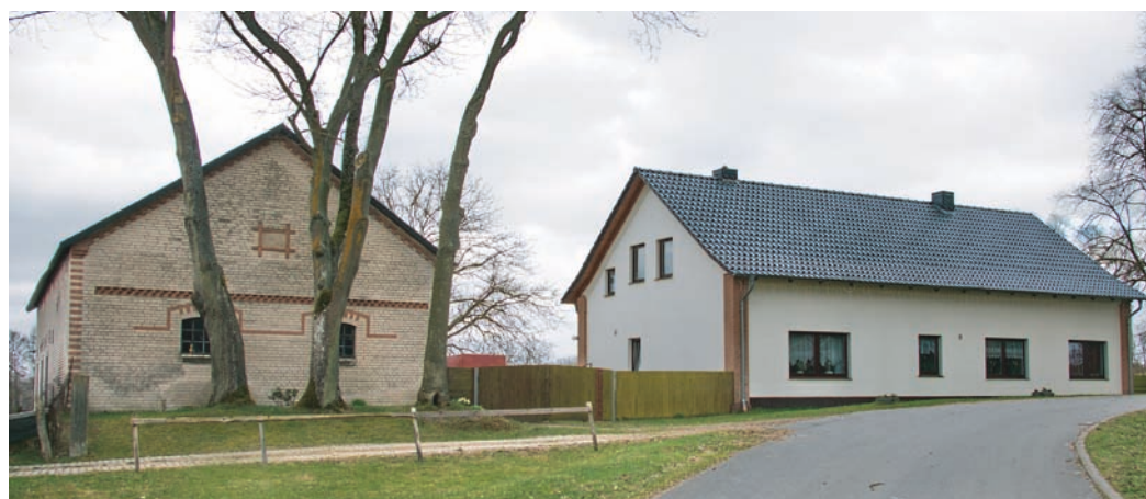
Wohnhaus und Stallgebäude eines ehemaligen Bauernhofes Residential and livestock buildings of former farmstead
