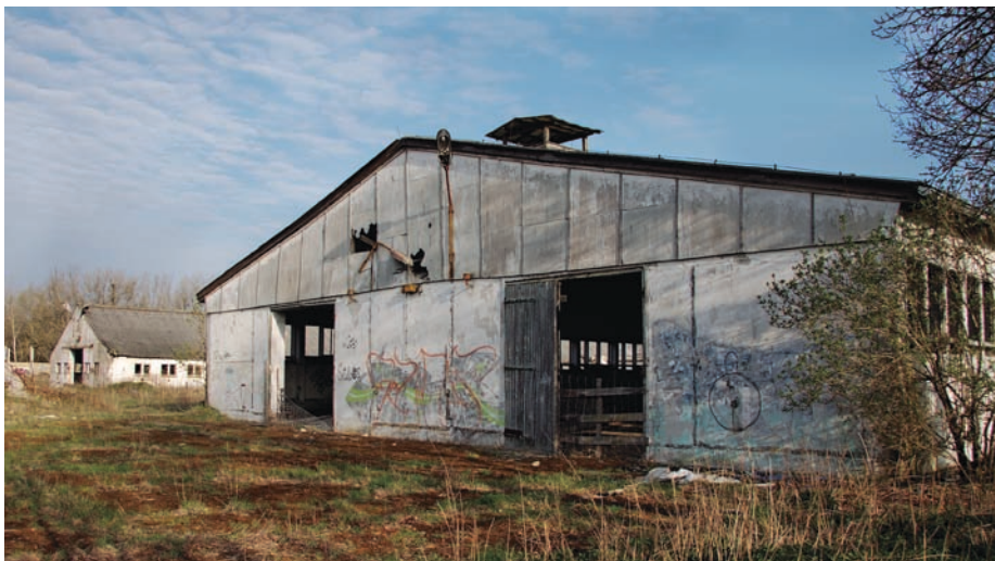
Alte Stallanlagen des VEG Krakow Old livestock buildings of VEG Krakow
