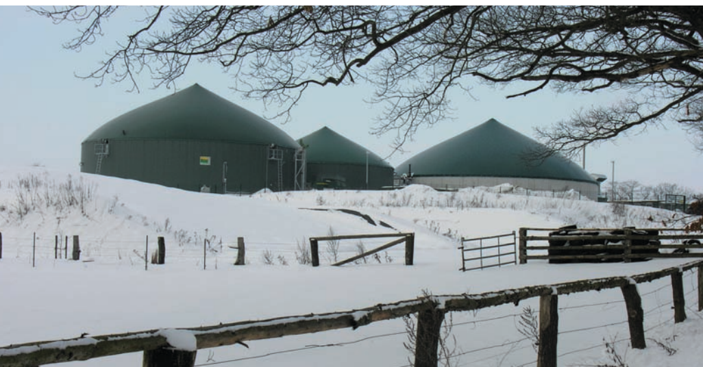
Moderne Biogasanlage zur Erzeugung von Elektroenergie Modern bio-gas fuelled generator for electricity
