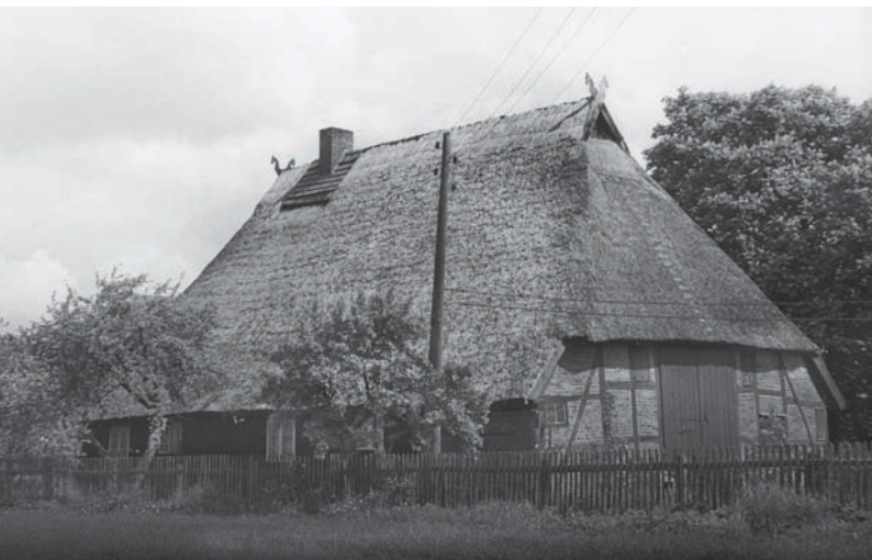
Das aus dem Jahr 1787 stammende Bauernhaus Güstrower Str. 2, 1968 Farm house from 1787 Güstrow Street 2 as in year 1968
