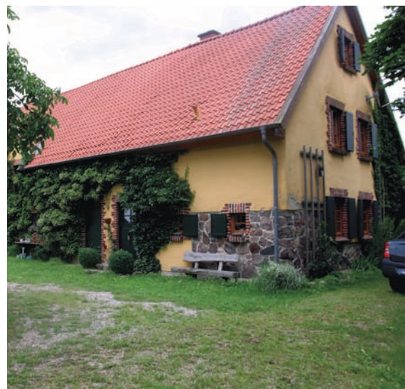
Ausgebaute Scheune des 1. Gehöftes (2011) Converted barn of 1st farmstead (2011)
