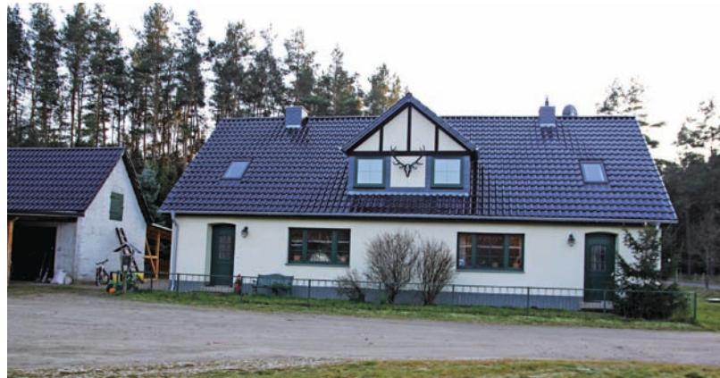
Umgebauter ehemaliger Forstarbeiterkaten Converted former forest worker cottage
