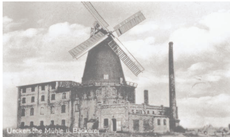
Ehemalige Windmühle und Dampfbäckerei in Silz Former wind mill and steam bakery in Silz
