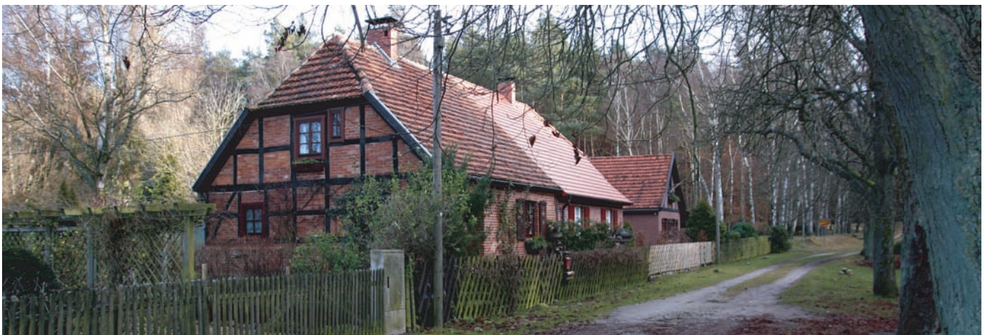
Ehemaliger Forstarbeiterkaten, Sandweg 3
