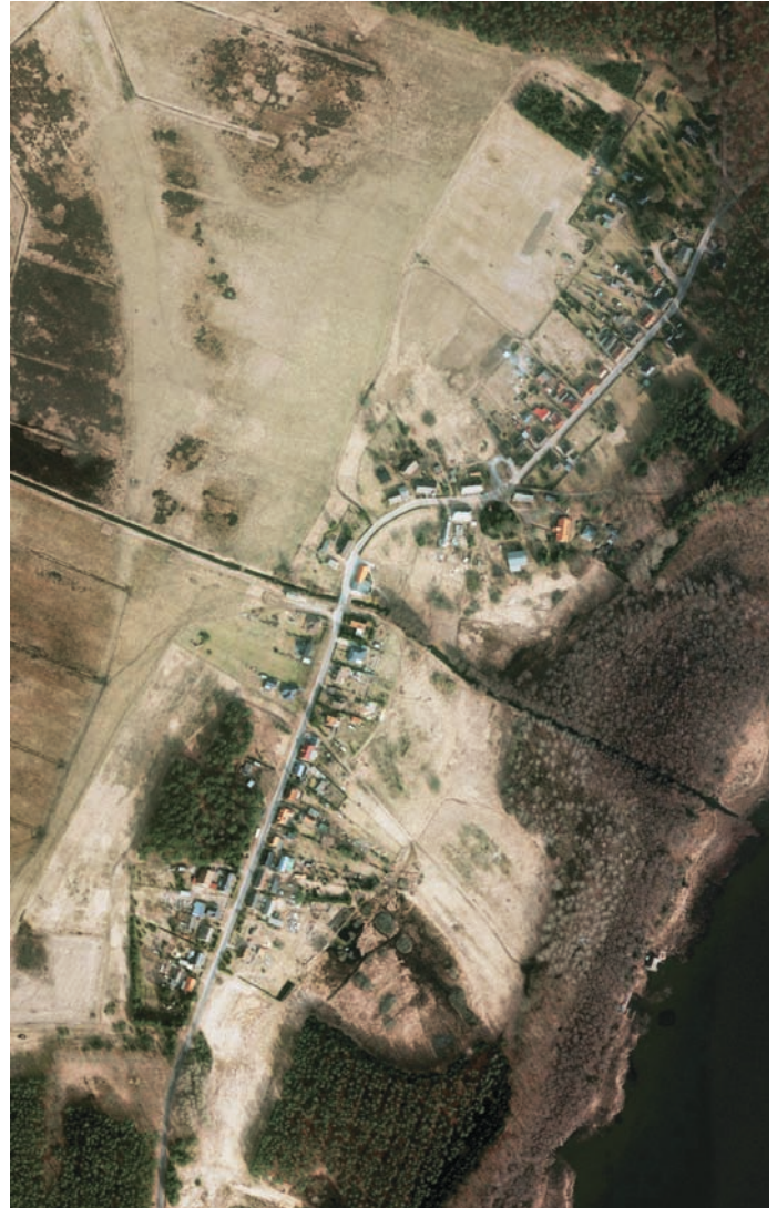
Luftbild des Straßendorfes Sandhof (2011) Aerial view of one-street-village Sandhof (2011)
