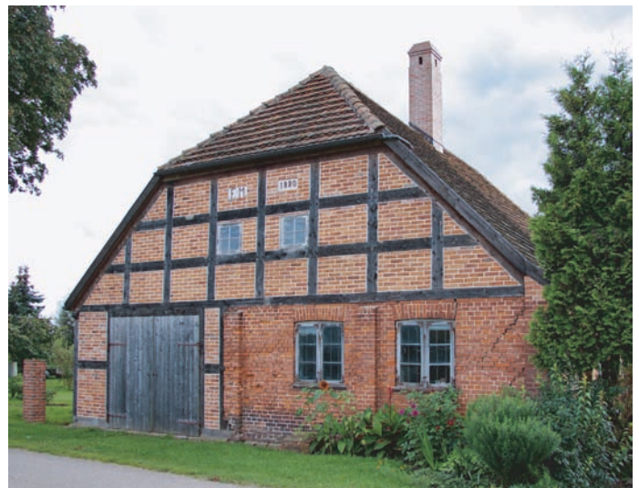
Denkmalgeschützte ehemalige Schmiede Dorfstr. 1 Listed former smithy Main Street 1
