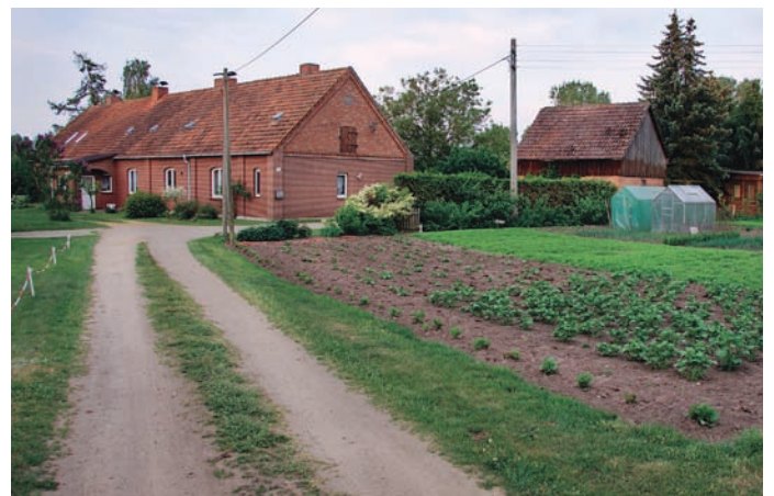
Ehemaliger Forstarbeiterkaten Former forest workers' cottage
