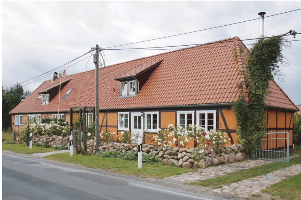
Ehemaliger Forstarbeiterkaten gegenüber dem Forsthof Former forest worker cottage vis-à-vis the forest courtyard
