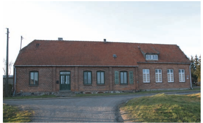
Die denkmalgeschützte ehemalige Schule (2011) Listed former school house (2011)
