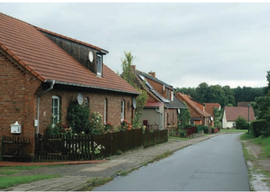
Forststraße mit ehemaligen Forstarbeiterkaten Forest road with former forest worker cottages
