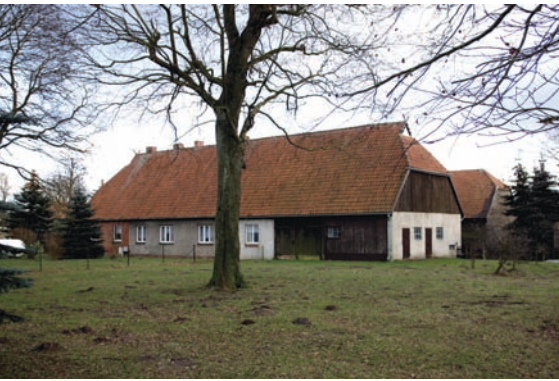
Einfirsthaus mit noch vorhandenem Wirtschaftsteil Single ridge house with subsisting farming part
