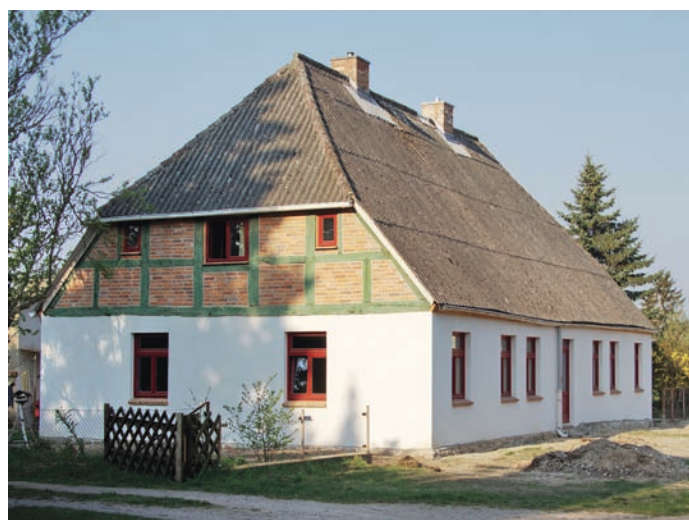
Ende des 18. Jh. erbauter ehemaliger Katen, der restauriert wird Former cottage from the end of the 18th century, now in renovation
