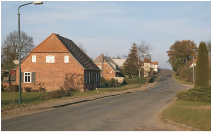
Ehemalige Büdnerie in der Langen Straße Former smallholding (Büdnerie) on Long Street
