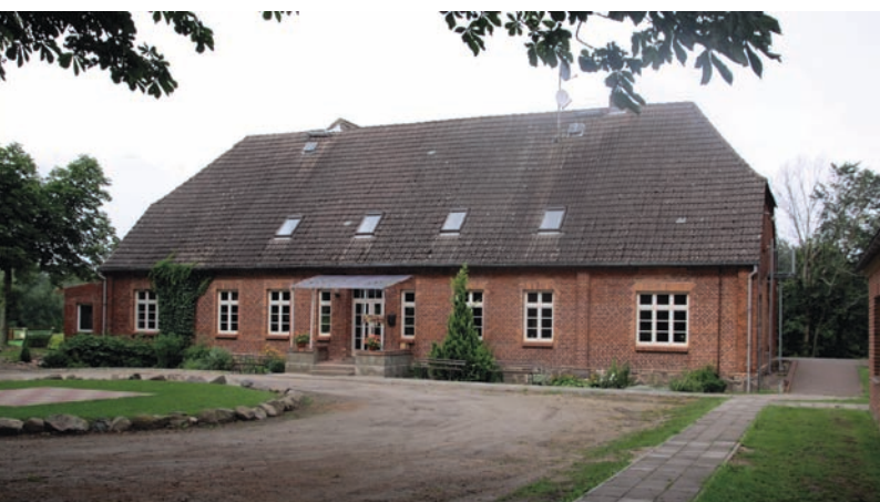
Pfarrhaus von 1870, das heute Tagungsheim der Kirche ist Vicarage from 1870, today serving for different kinds of conventions
