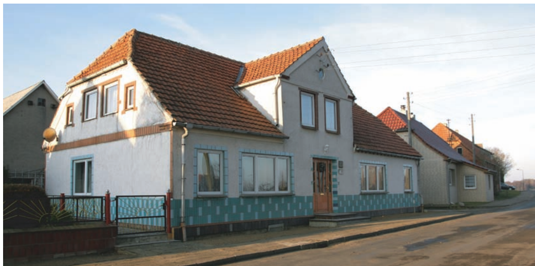
Ehemalige Büdnerei II, die eine Gastwirtschaft betrieb Former smallholding II (Büdnerei) which ran a pub
