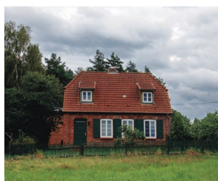
Wohnhäuser ehemaliger Häuslereien Dwellings of former smallholdings (Häuslereien)
