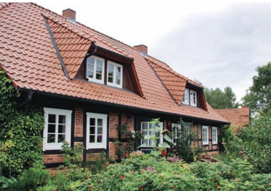
Modernisierter Doppelkaten Modernized cottage for two families
