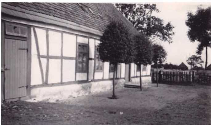
Gehöft Richter 1960 (Innenhof) Richter's farmstead 1960 (inner courtyard)
