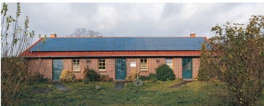
Anstelle eines baufälligen Stallgebäudes entstand ein Flachbau Instead of a dilapidated livestock building created a low-rise building
