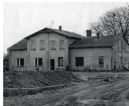
„Thomashof“ vor der Sanierung „Thomashof“ before renovation
