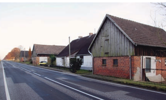
Wohnhaus des Forsthofes (oben) und ehemalige Forstarbeiterkaten mit Stallgebäuden an der Schnaterei (unten)
