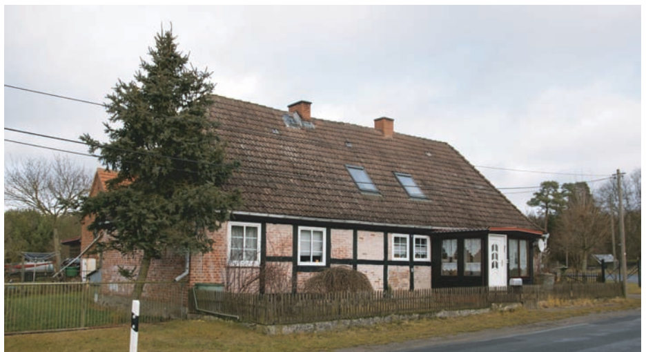
Ehemaliger Forstarbeiterkaten gegenüber dem Forsthof Former forest worker cottage vis-à-vis the forest courtyard
