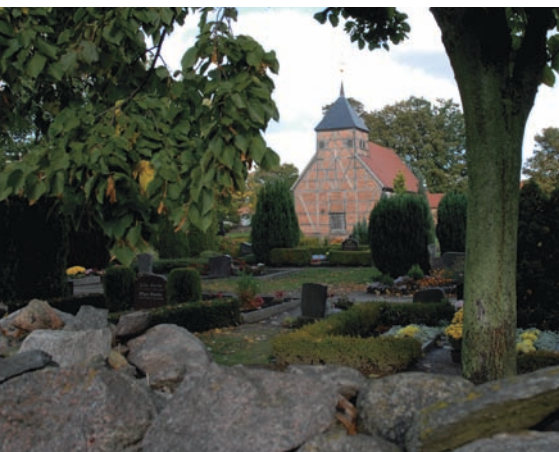
Fachwerkkirche mit Feldsteinmauer Half-timbered church with wall of rocks
