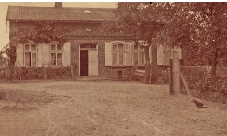
Das alte Wohnhaus des Müllers von vor 1945 The miller's old homestead from before 1945
