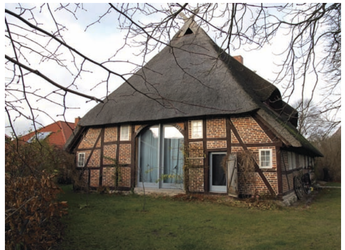
Der Zustand dieses Hauses 2011 Same house as of 2011
