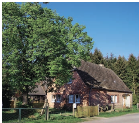
Wohnhaus aus den 1920er Jahren Residence from the 1920s
