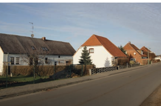
Häuslerzeile an der Straße nach Woosten Row of smallholdings (Häusler) along road to Woosten
