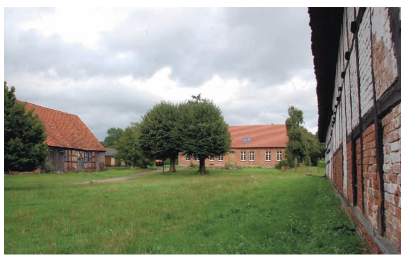
Der denkmalgeschützte Pfarrhof mit Wohnhaus, Stall und Scheune Listed vicarage with residence, livestock building and barn
