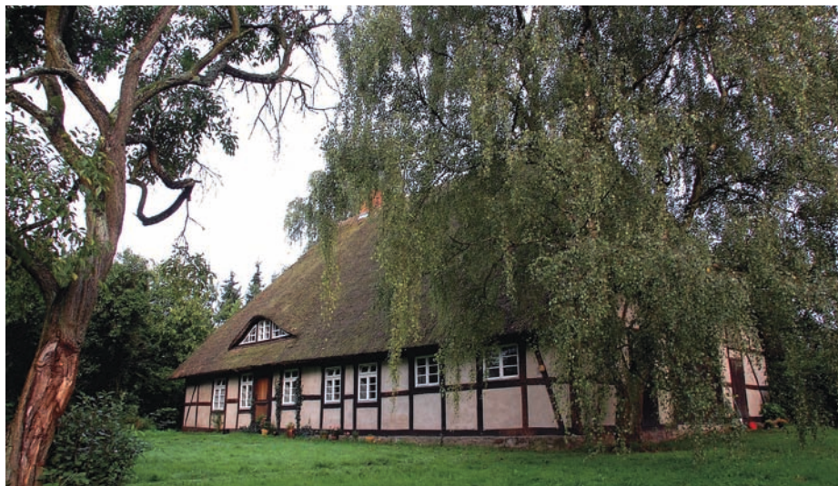
Seitenansicht (Nordseite) des Hallenhauses (2011) Lateral view (north side) of aisled house (2011)
