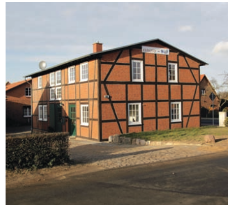
Ausgebaute Scheune einer ehemaligen Büdneri Converted barn of former smallholding (Büdneri)
