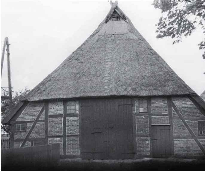
Hallenhaus in Dobbertin aus dem Jahr 1787 (Zustand 1968) Aisled house in Dobbertin from 1787 (condition 1968)
