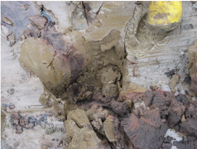
Abb. 6: Fortsetzung der zentral in den Rinnenstrukturen angeordneten rötlichen Sande in die Tiefe (durch Schadstoffe farblich verändert; Stiefelspitze als Maßstab).
