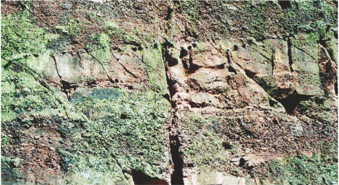
Abb. 33: Im Nahbereich der Abschiebungen zusätzlich zu den normalen Klufflächen ausgebildete Schrägklüfte am Weinberg Augenscheiner.
