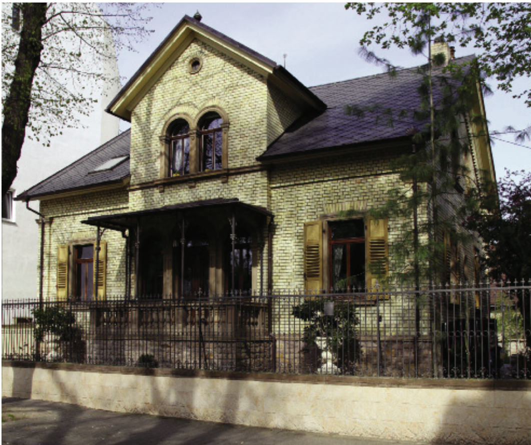
Abb. 11: Wohnhaus in Ziegelbauweise in Wöllstein, Bahnhofstraße (Foto: HÄFNER 2015).
