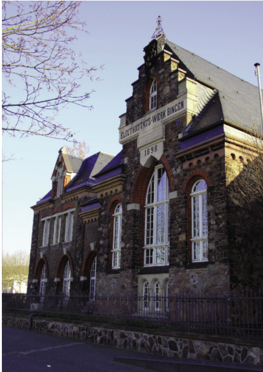
Abb. 29: Mauerwerk aus Sandsteinen (Grauwacken) des rheinischen Schiefergebirges in Bingerbrück; ehemaliges Elektrizitätswerk, errichtet 1898 (Foto: HÄFNER 2011).
