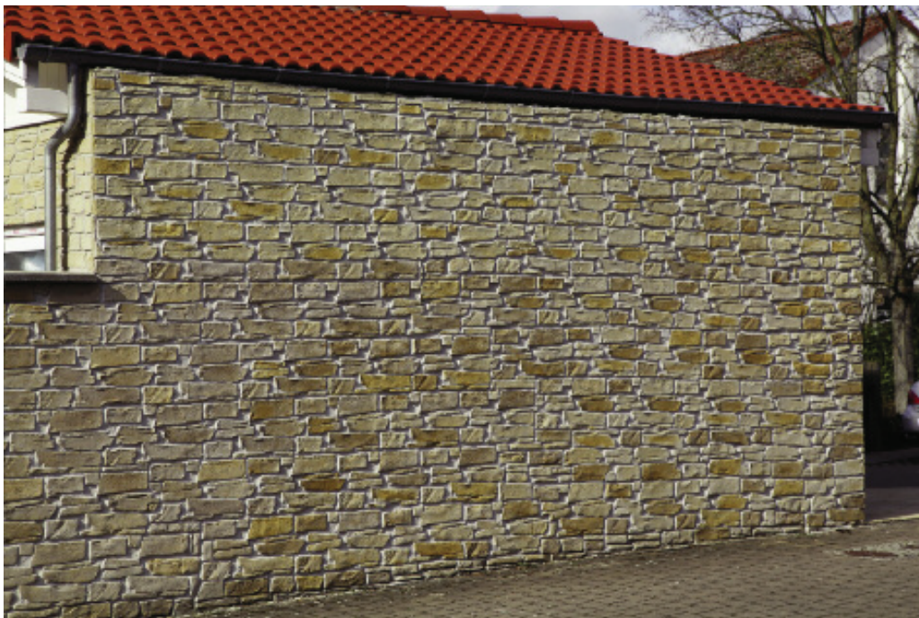
Abb. 2: Naturstein-Imitat („Kalkstein“) aus Beton als Wandbaustoff (Foto: HÄFNER 2015).
