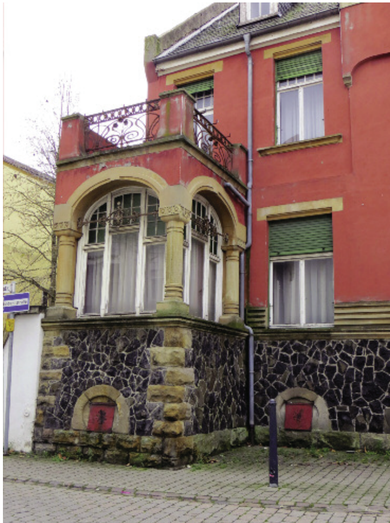
Abb. 27: Sockelverblendung mit Andesit in Alzey, Wohnhaus Augustinerstraße (Foto: HÄFNER 2013).
