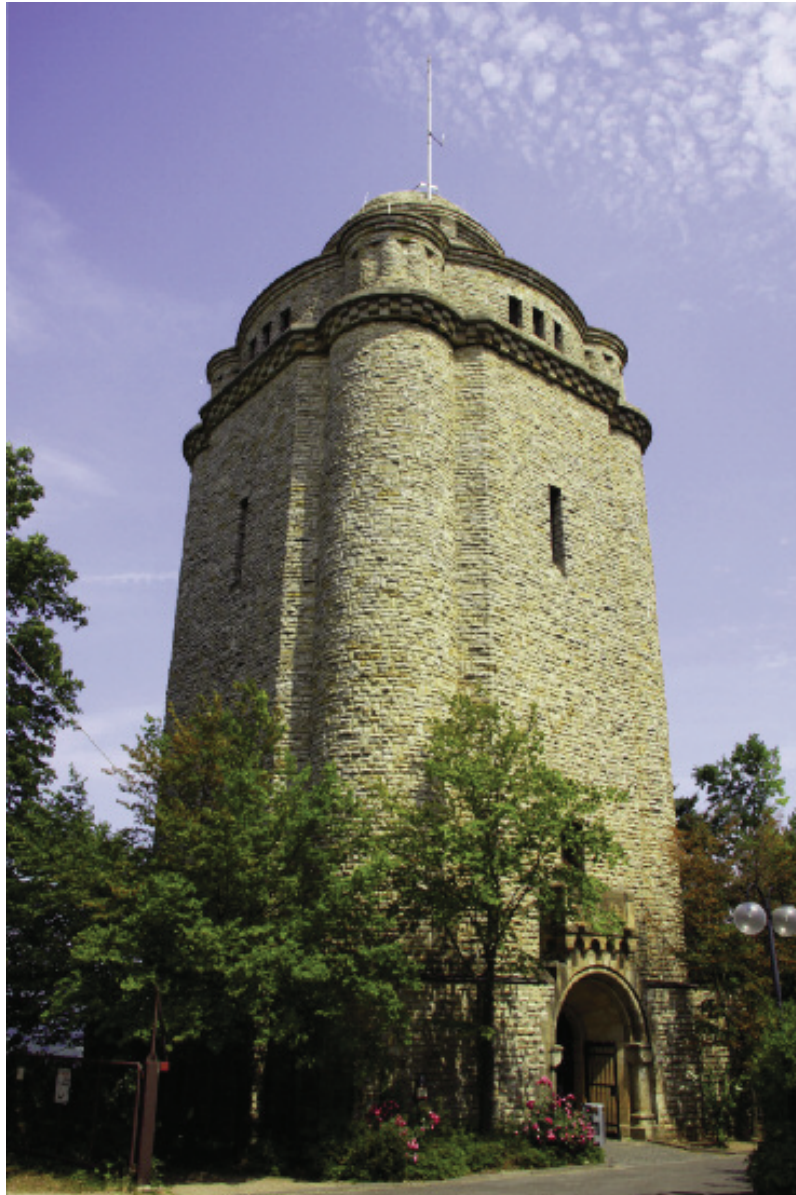
Abb. 6: Bismarckturm auf dem Westerberg bei Ingelheim aus Kalksteinen und Flonheimer Sandstein (Foto: HÄFNER 2011).
