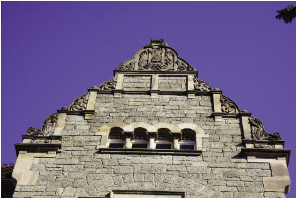
Abb. 28: Detail des Giebels der Villa Katharina, Schillerstraße, Bingen. Errichtet aus Quarzit (Foto: HÄFNER 2011).
