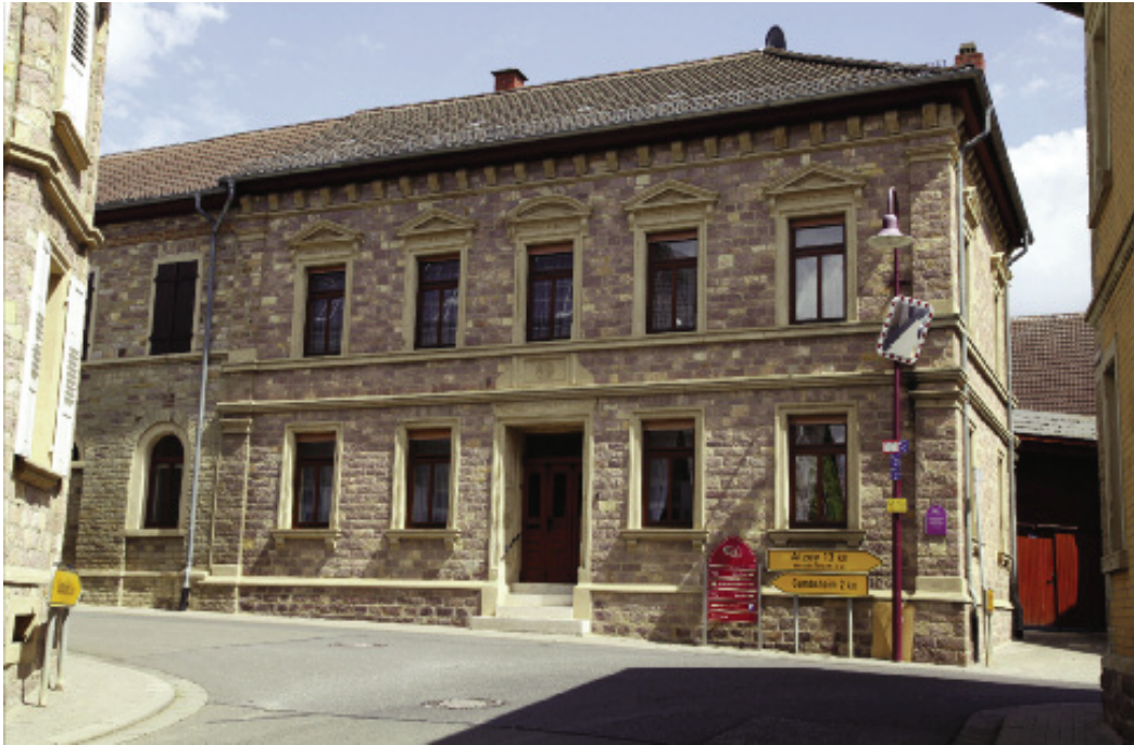
Abb. 25: Wohnhaus in Eckelsheim (Denkmalzone); Schichtmauerwerk aus Rhyolith (Foto: HÄFNER 2014).
