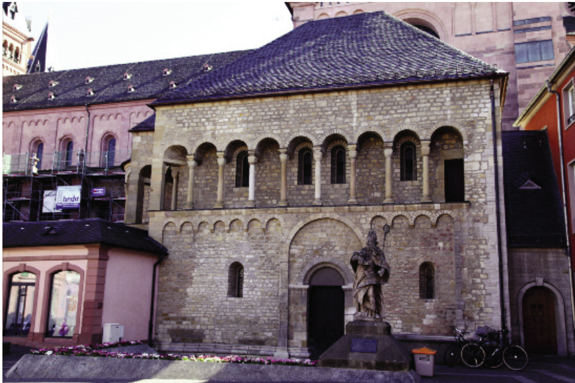
Abb. 5: Gotthardkapelle neben dem Mainzer Dom, errichtet aus rheinhessischen Kalksteinen (Foto: HÄFNER 2012).
