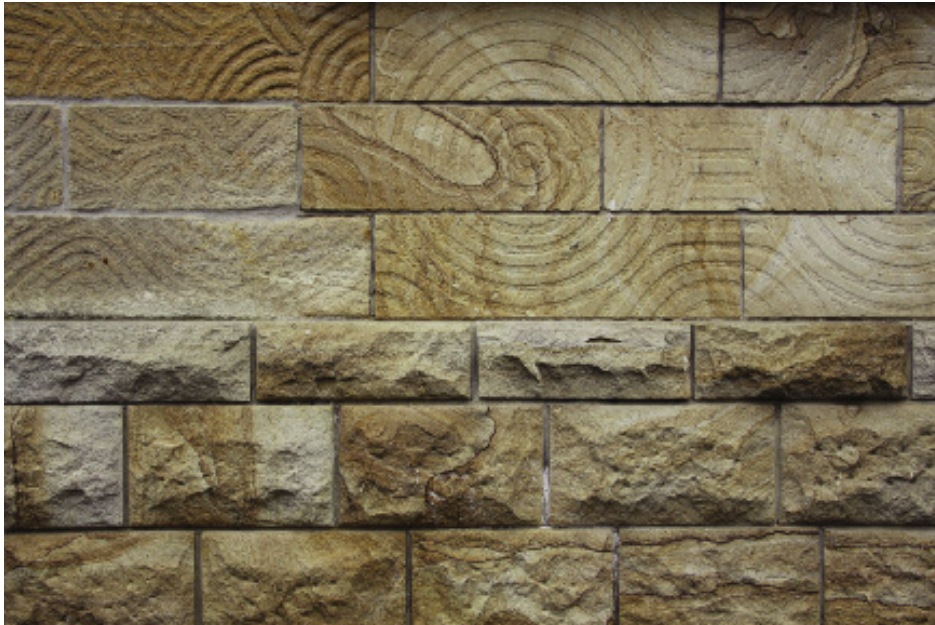
Abb. 18: Detail mit aufwendiger Steinbearbeitung der Fassade des Bürgerhauses (früher Schulhaus) in Nack aus Flonheimer Sandstein (Foto: HÄFNER 2011).
