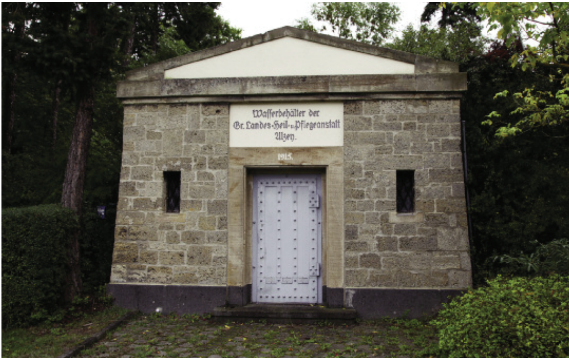
Abb. 9: Wasserhochbehälter der Landesheil- und Pflegeanstalt Alzey (jetzt Rheinhessen-Fachklinik) am Wartberg, Landesstraße L 401, aus Kalksteinen des Cyrenenmergels mit ausgeprägter Fossilführung (Foto: HÄFNER 2013).
