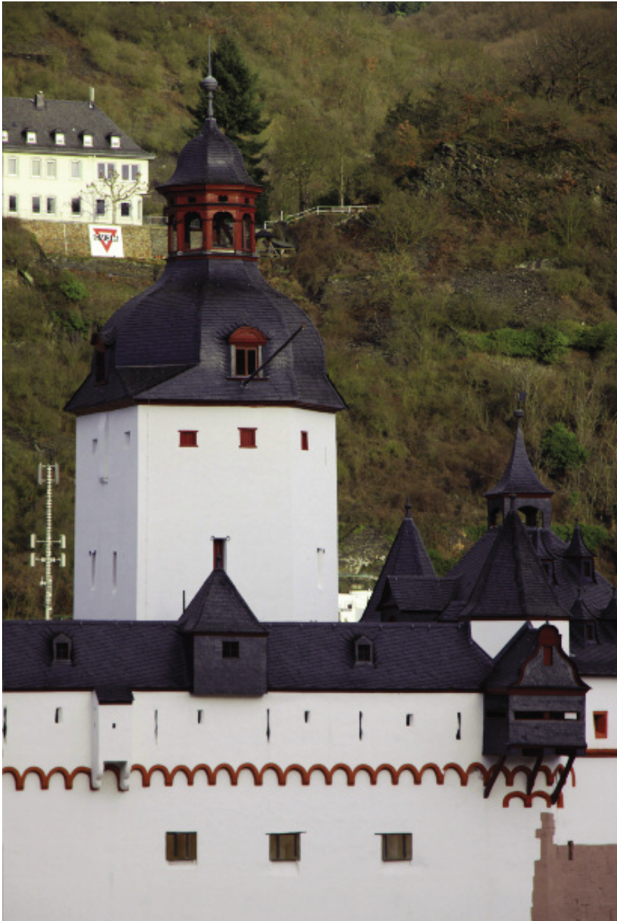
Abb. 30: Dacheindeckung mit Schiefer: Pfalz bei Kaub im Mittelrheintal (Foto: HÄFNER 2013).
