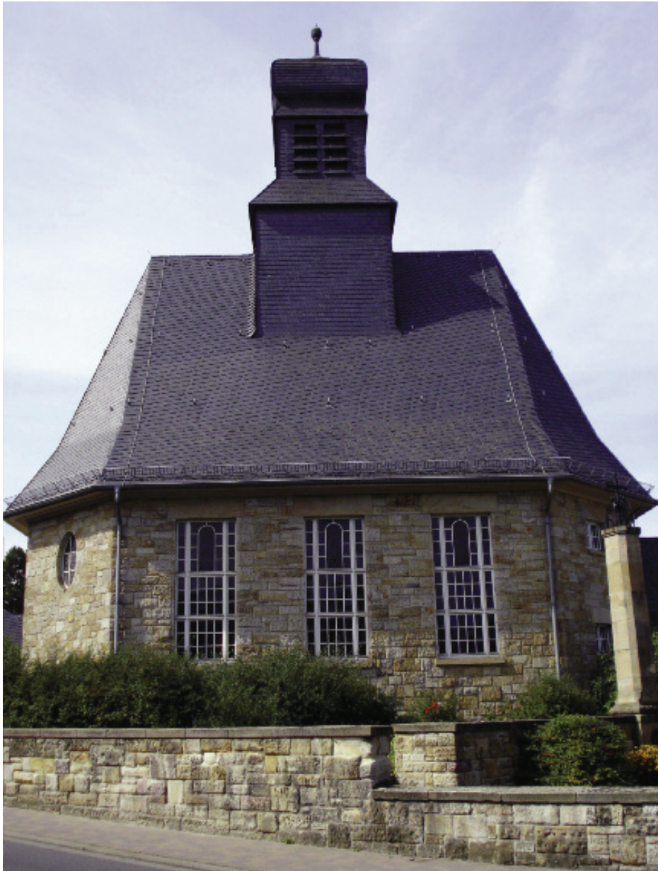
Abb. 15: Aus Flonheimer Sandsteinen 1912 bis 1913 errichtete evangelische Pfarrkirche in Budenheim (Foto: HÄFNER 2008).
