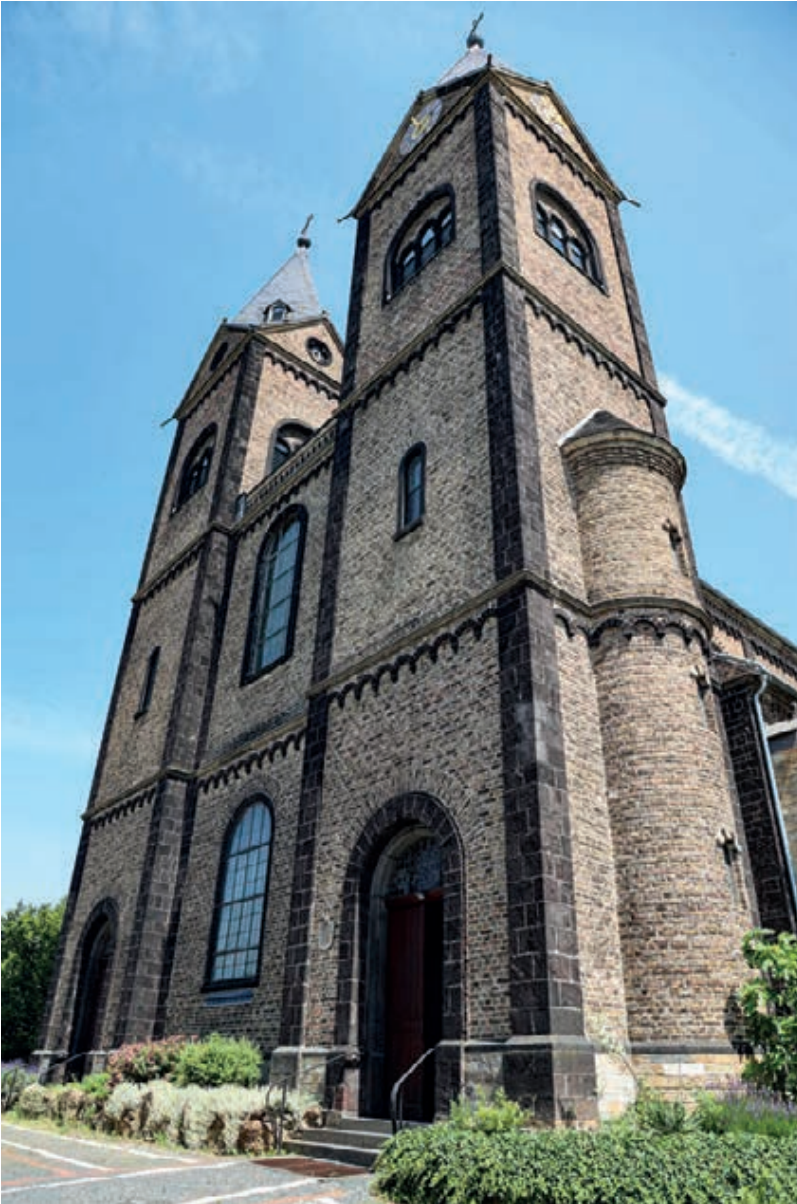
Abb. 3: Teilansicht der Kirche St. Nikolaus in Arenberg von Südwesten.
