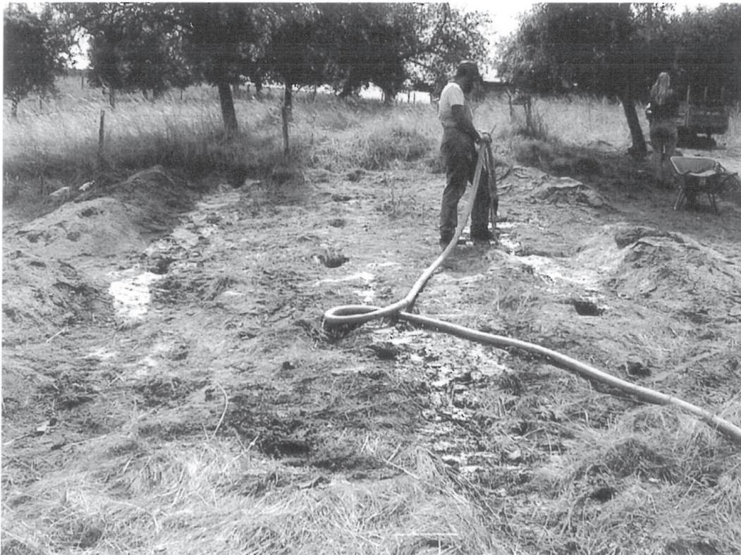
Abb. 5: Einbau der Injektionspfähle.
