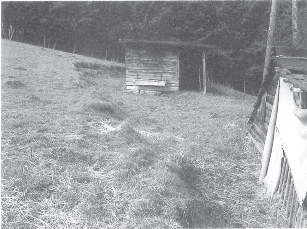
Abb. 3: Hauptabriss der Rutschung an den Schafställen.
