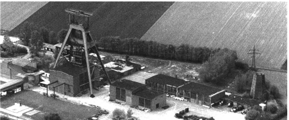
Luftaufnahme der Schachanlage Konrad 1 mit Fördersturm, Werkstattbereich und Sozialgebäuden
