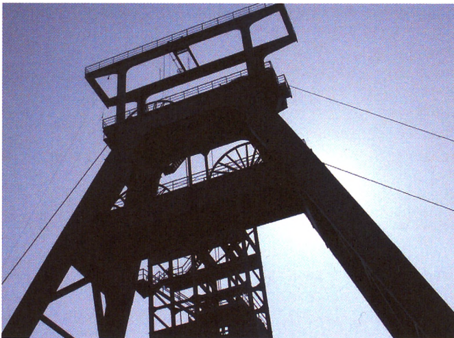
Fördergestell Schacht Konrad, Salzgitter (Foto: Peter Schulze)
