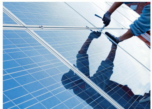
Abbildung 1: Dickschichtzellen der kristallinen Siliziumwafer-Technologie dominieren den globalen PV-Markt (Bildquelle: Fotolia @Simon Kraus).
