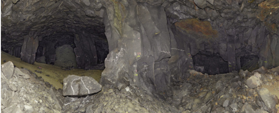
Abb. 3: Untertägiger Grubenbau in Niedermendig mit natürlichen Restpfeilern aus Basalt. Rechts vom Pfeiler in der Bildmitte ist ein Firstausbruch vorhanden. Oben rechts im Bild befindet sich ein Red Crack an der Firste. Im Bildhintergrund links ist ein Schüttkegel eines verfüllten Schachts zu erkennen. Es ist typisch, dass rund um den Schacht drei Restpfeiler zur Stabilisierung des Hohlraums stehen gelassen wurden (Foto: TeamXmedia 23.10.2012 im Auftrag des Landesamtes für Geologie und Bergbau Rheinland-Pfalz).
