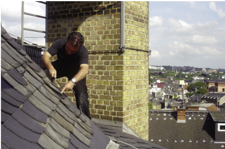
Abb. 12: Probenahme auf dem Dach der Kaiser-Friedrich-Therme/Wiesbaden.
