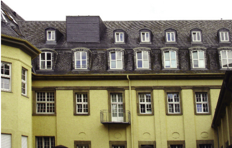
Abb. 11: Auf dem Dach der Kaiser-Friedrich-Therme/Wiesbaden sind trotz zahlreicher neuer Einbauten noch große Teile der Originaldeckung mit Kauber Schiefer (Unterems-Stufe, Unterdevon) erhalten geblieben (wie Abb. 9a oben).
